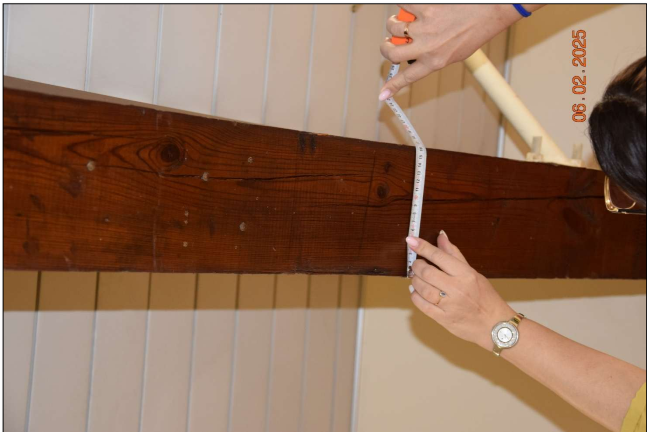
Fot. 166 Szerokość dźwigara 16 cm – zgodnie z dokumentacją projektową. (fot. Rafał Fit)
