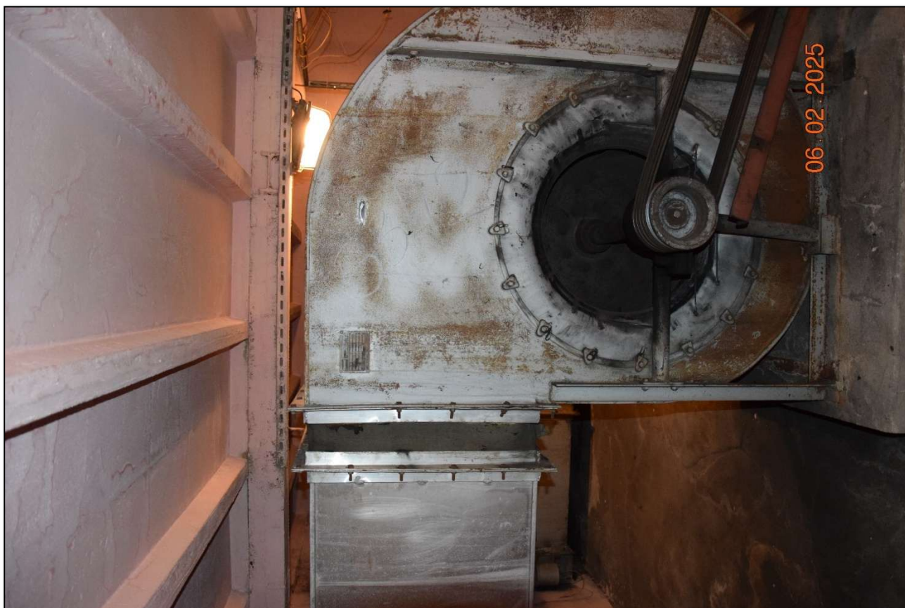
Fot. 213 Urządzenia wentylatorowe – stan techniczny zły. Skorodowane obudowy, brak osłon zabezpieczających .(fot. Rafał Fit)
