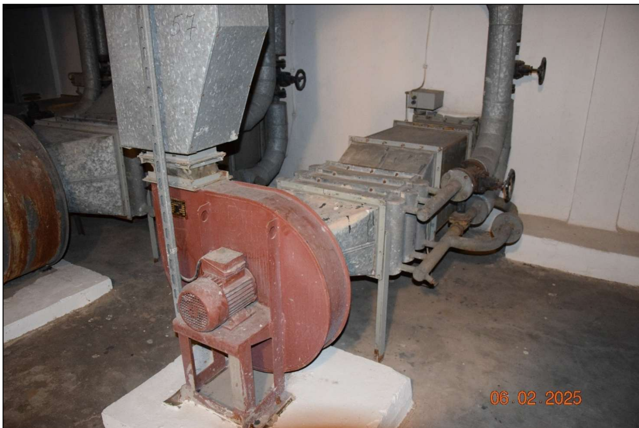
Fot. 208 Instalacje uzdatniania powietrza starego typu. Rozwiązanie mało efektywne. Ślady utlenienia powłoki ochronnej kanałów świadczą o zużyciu eksploatacyjnym tych elementów. (fot. Rafał Fit)
