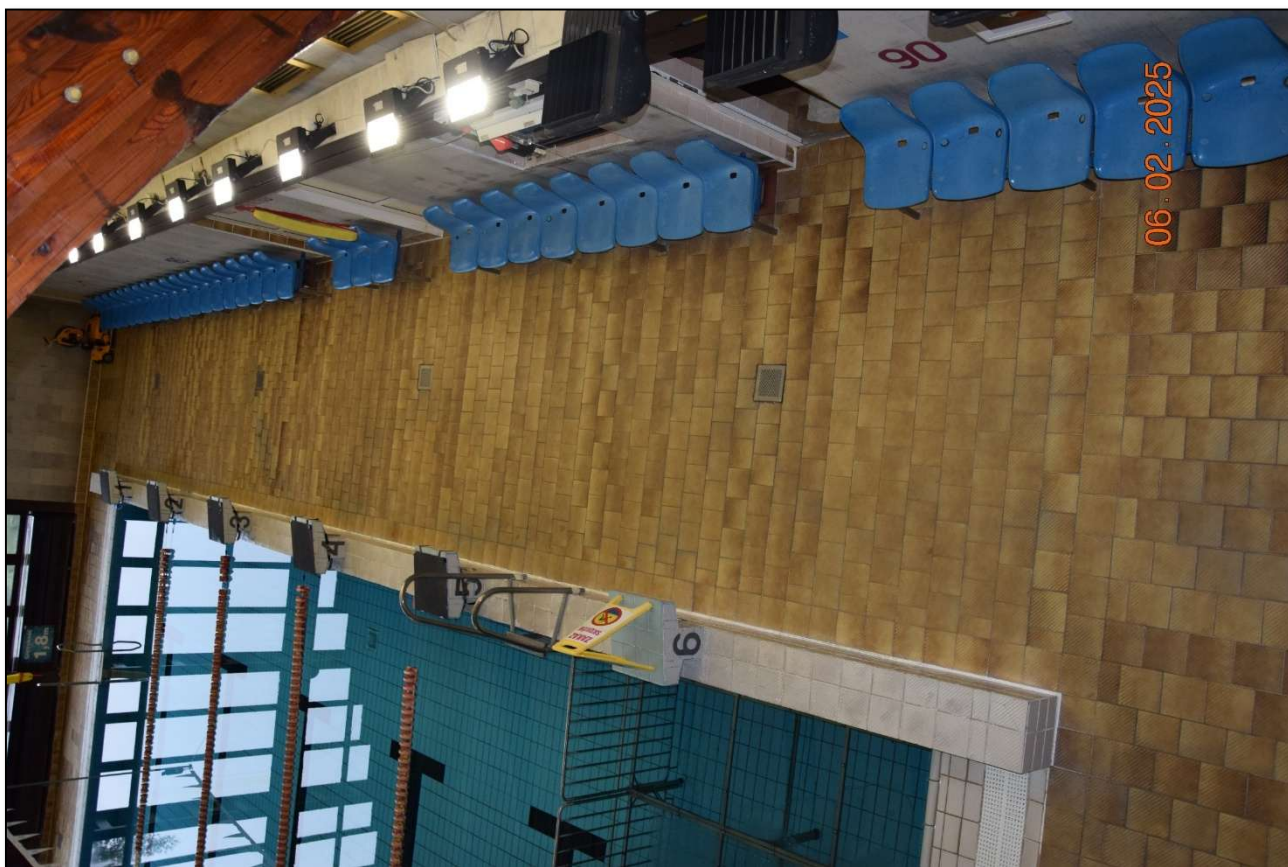
Fot. 239. Widok ogólny zdegradowanych posadzek ceramicznych w pomieszczeniach technicznych basenu. Stan techniczny – zły. (fot. Rafał Fit)
