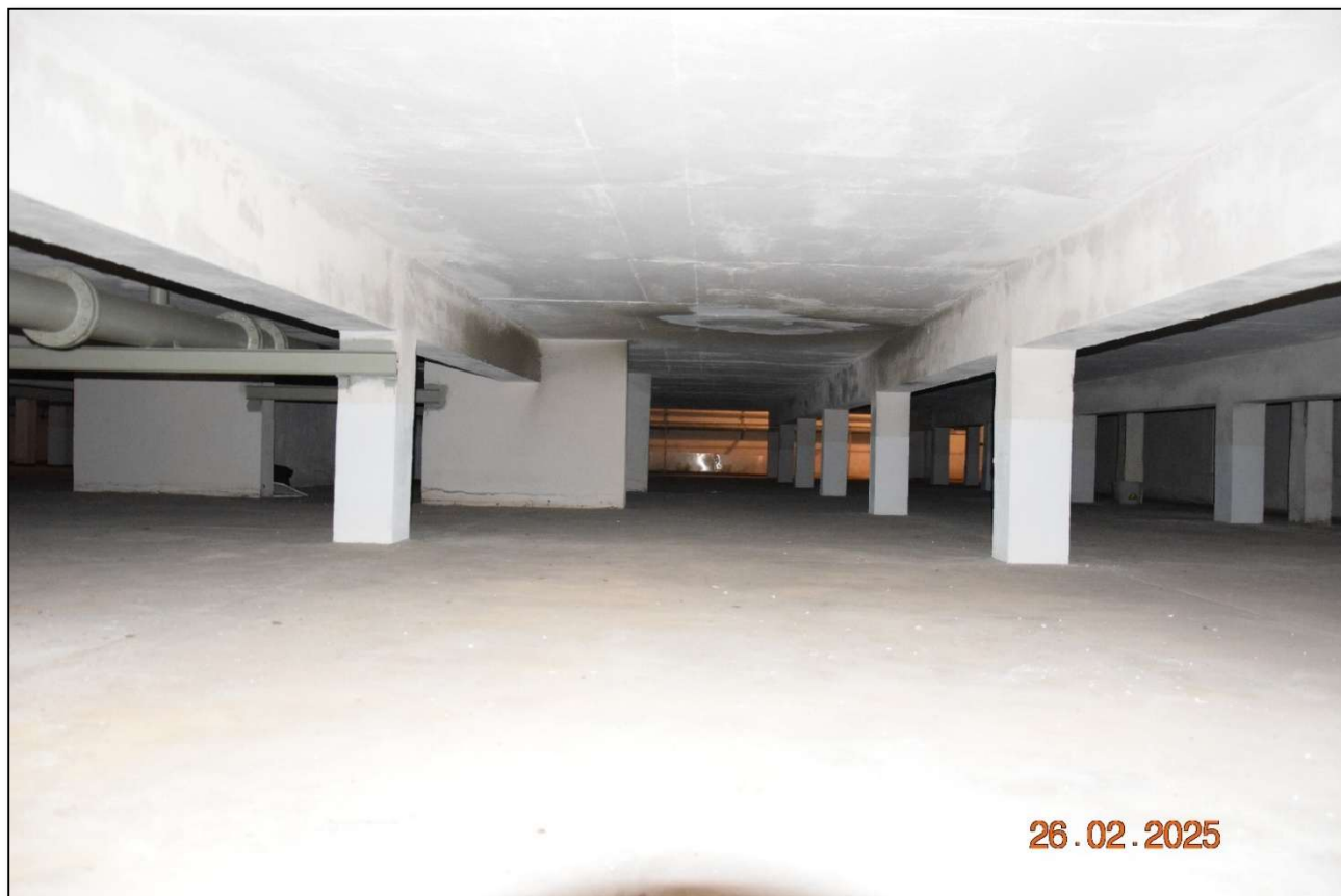
Fot. 27. Brak widocznych śladów nieszczelności płyty stropowej basenu – stan techniczny dobry. (fot. Rafał Fit)
