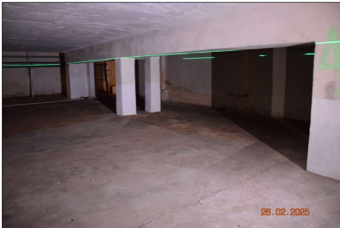
Fot. 25. Inwentaryzacja ugięć i zarysowań belek wieloprzęsłowych – stan techniczny dobry, brak oznak ugięć oraz rys w przęsłach i nad podporami. (fot. Rafał Fit)
