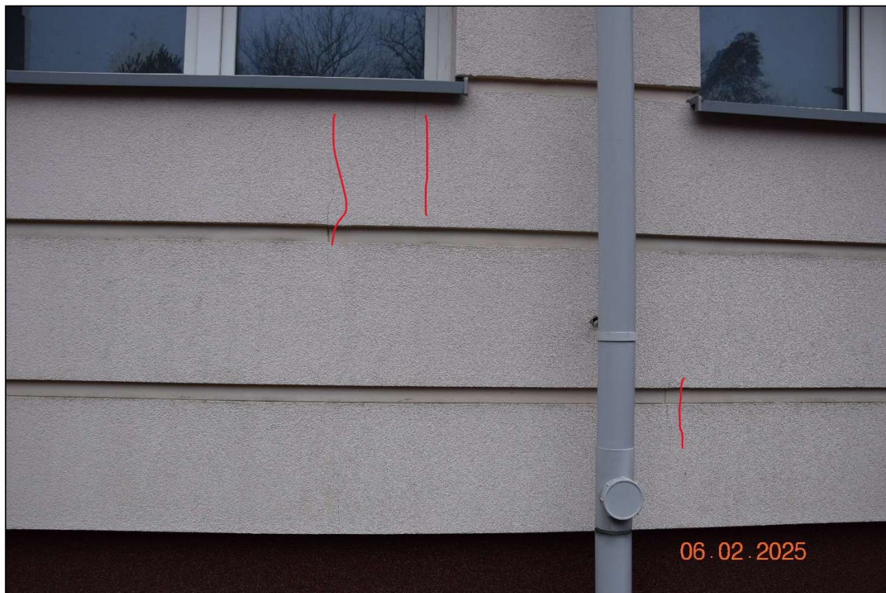
Fot. 140 widok ogólny uszkodzeń elewacji wykonanej w systemie ETICS spowodowane błędami wykonawczymi i okresem eksploatacji. Stan techniczny – dostateczny. (fot. Rafał Fit)
