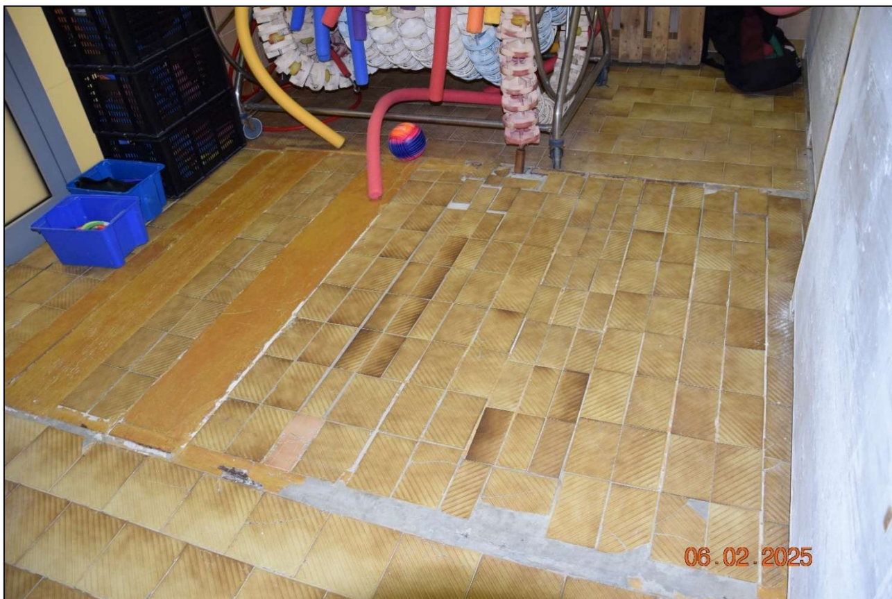
Fot. 242. Widok ogólny zdegradowanych posadzek ceramicznych w pomieszczeniach technicznych basenu. Stan techniczny – zły. (fot. Rafał Fit)
