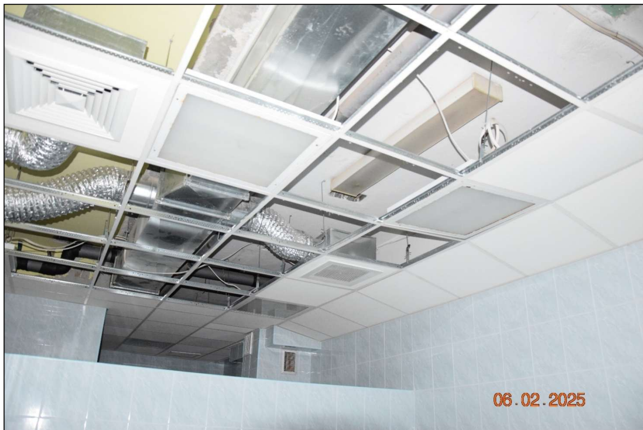
Fot. 248 Niewłaściwie zaprojektowana i wykonana instalacja wentylacji. Zastosowano wentylację mechaniczną w połączeniu z grawitacyjną. (fot. Rafał Fit)
