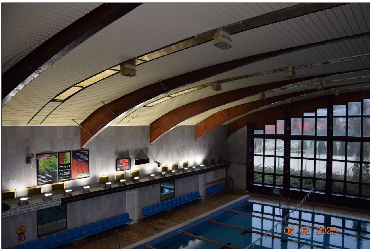
Fot. 169 Widok ogólny stanu technicznego dźwigarów w hali basenowej – bez uwag. (fot. Rafał Fit)
