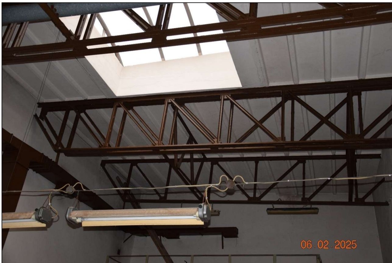
Fot. 200 Oświetleniowe instalacje elektryczne starego typu. Stan techniczny dostateczny. Zalecana wymiana na ekonomiczne oświetlenie typu LED. (fot. Rafał Fit)
