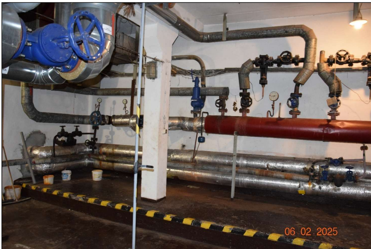
Fot. 206 Widok ogólny instalacji grzewczej. Widoczne ślady przecieków i rdzawych nalotów świadczą o wyeksploatowaniu materiałów z których została ona wykonana. Zalecany remont generalny instalacji. (fot. Rafał Fit)
