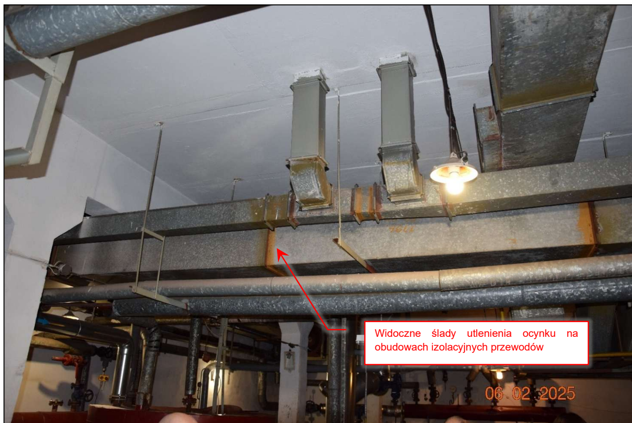
Fot. 203 Widoczne zużycie kanałów wentylacyjnych wykonanych z blachy ocynkowanej. Stan techniczny - zły. Zalecana wymiana. (fot. Rafał Fit)
