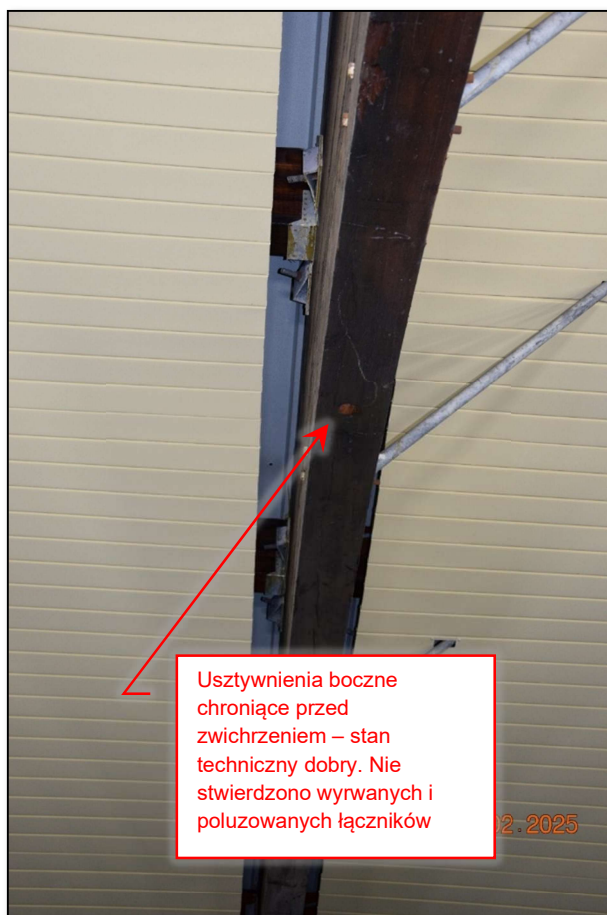
Fot. 90 Analiza stanu technicznego drewnianych dźwigarów hali basenowej (fot. Rafał Fit).
