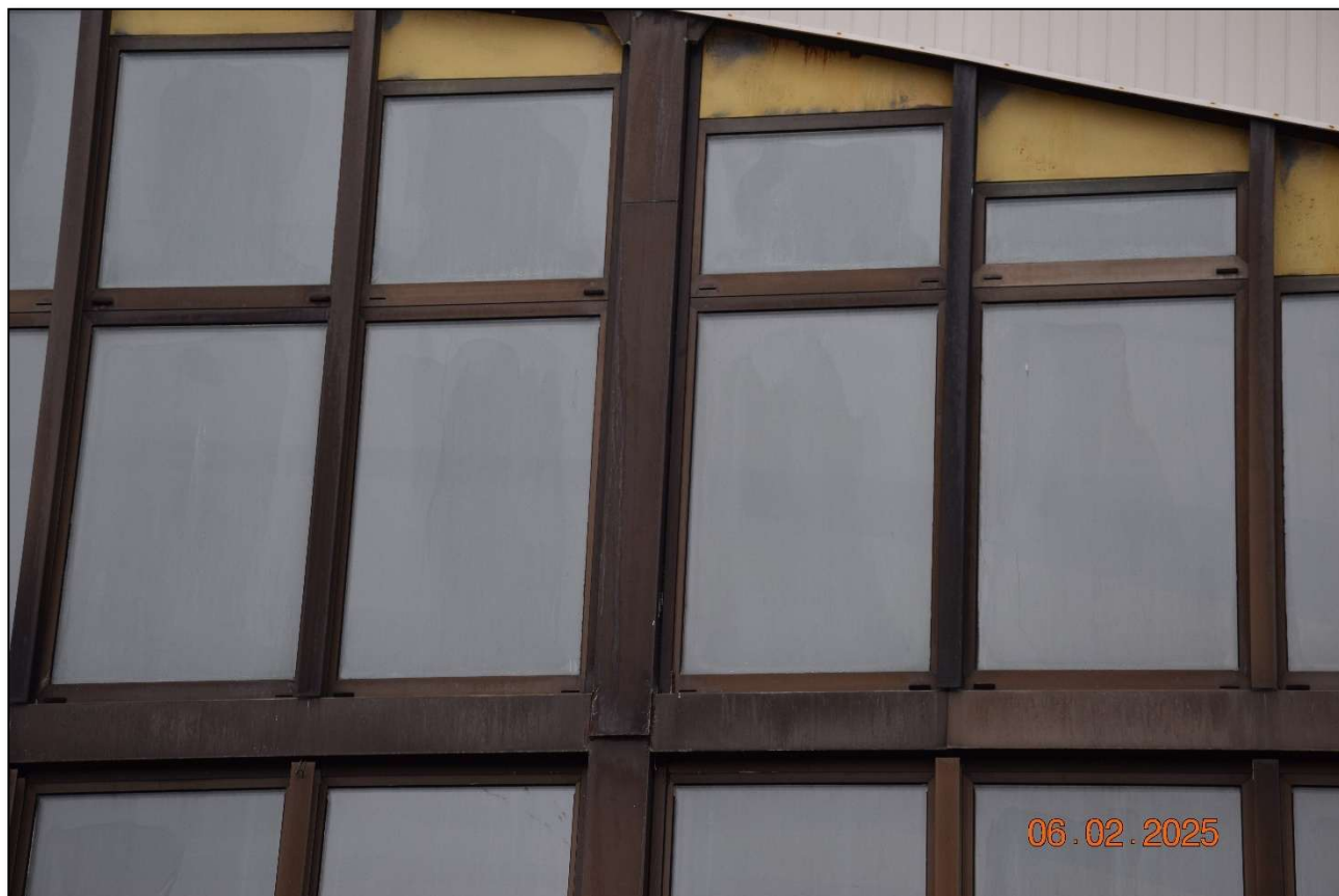
Fot. 146 Widoczne ślady gromadzenia się pary wodnej na wewnętrznej stronie szklenia świadczą o uszkodzonej izolacyjności pakietów szybowych – stan techniczny zły. (fot. Rafał Fit)
