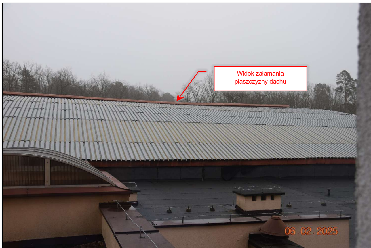
Fot. 126 Widok ogólny załamania płaszczyzny dachu. Analiza przyczyny w treści opracowania. (fot. Rafał Fit)
