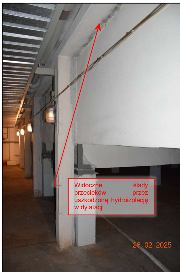
Fot. 228 Inwentaryzacja stanu technicznego konstrukcji nośnej w pomieszczeniu technicznym niecki basenowej – stan techniczny dostateczny. (fot. Rafał Fit)
