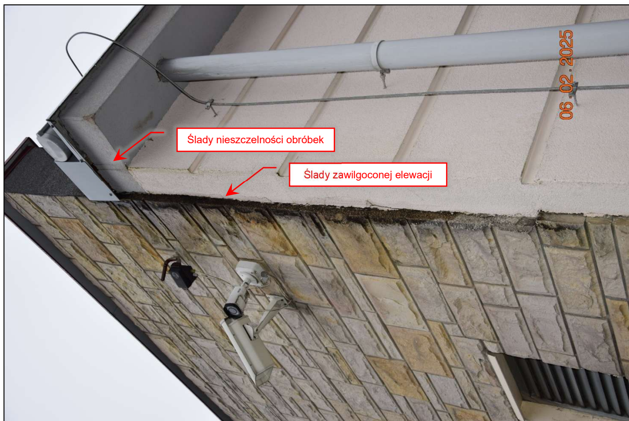
Fot. 137 Detal niewłaściwie ukształtowanego połączenia dwóch rodzajów elewacji oraz brak szczelności izolacji na attyce powoduje wnikanie wody pod elewację (fot. Rafał Fit)
