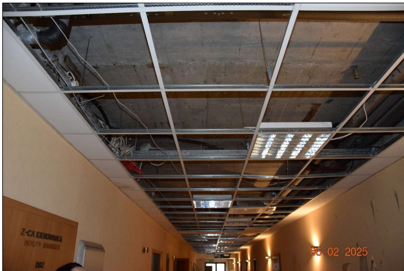
Fot. 244. Widok ogólny stropodachu żelbetowego – stan techniczny dobry. (fot. Rafał Fit)
