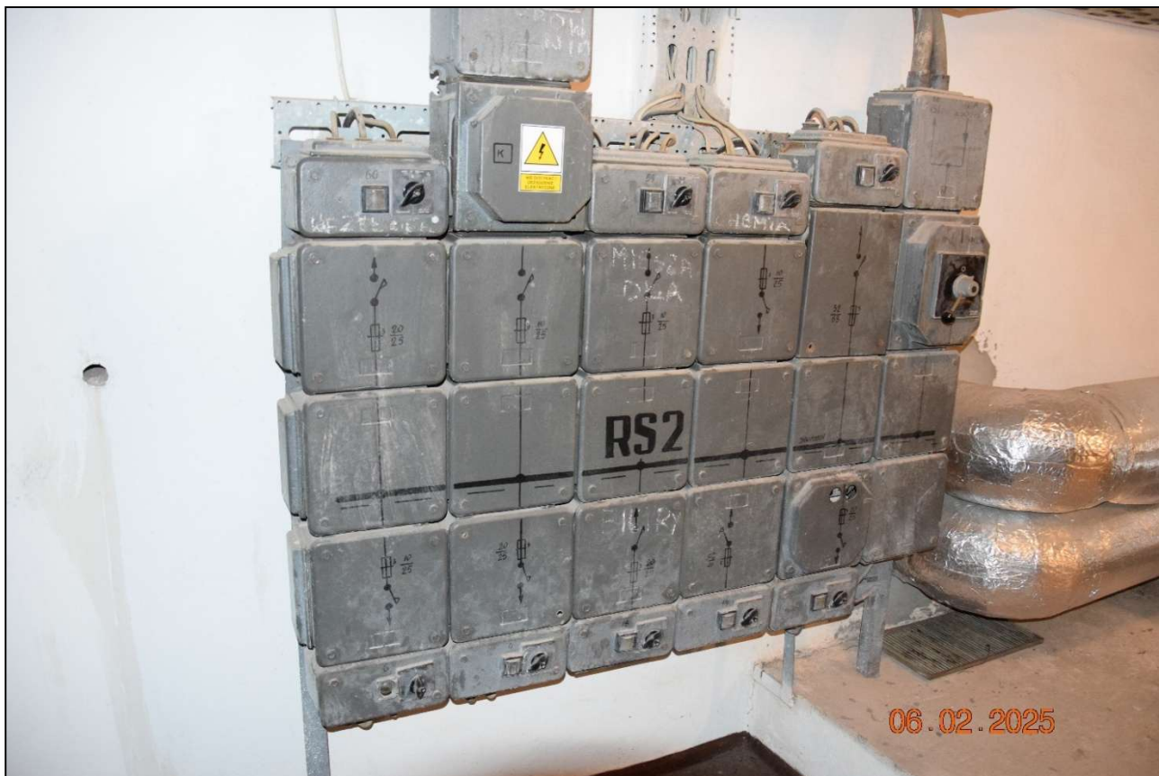
Fot. 211 Wewnętrzne rozdzielnie elektryczne rozdziału mocy starego typu. Zalecana wymiana na nowe zunifikowane systemowe szafowe z możliwością instalacji aparatów bezpiecznikowych i różnicowoprądowych. (fot. Rafał Fit)
