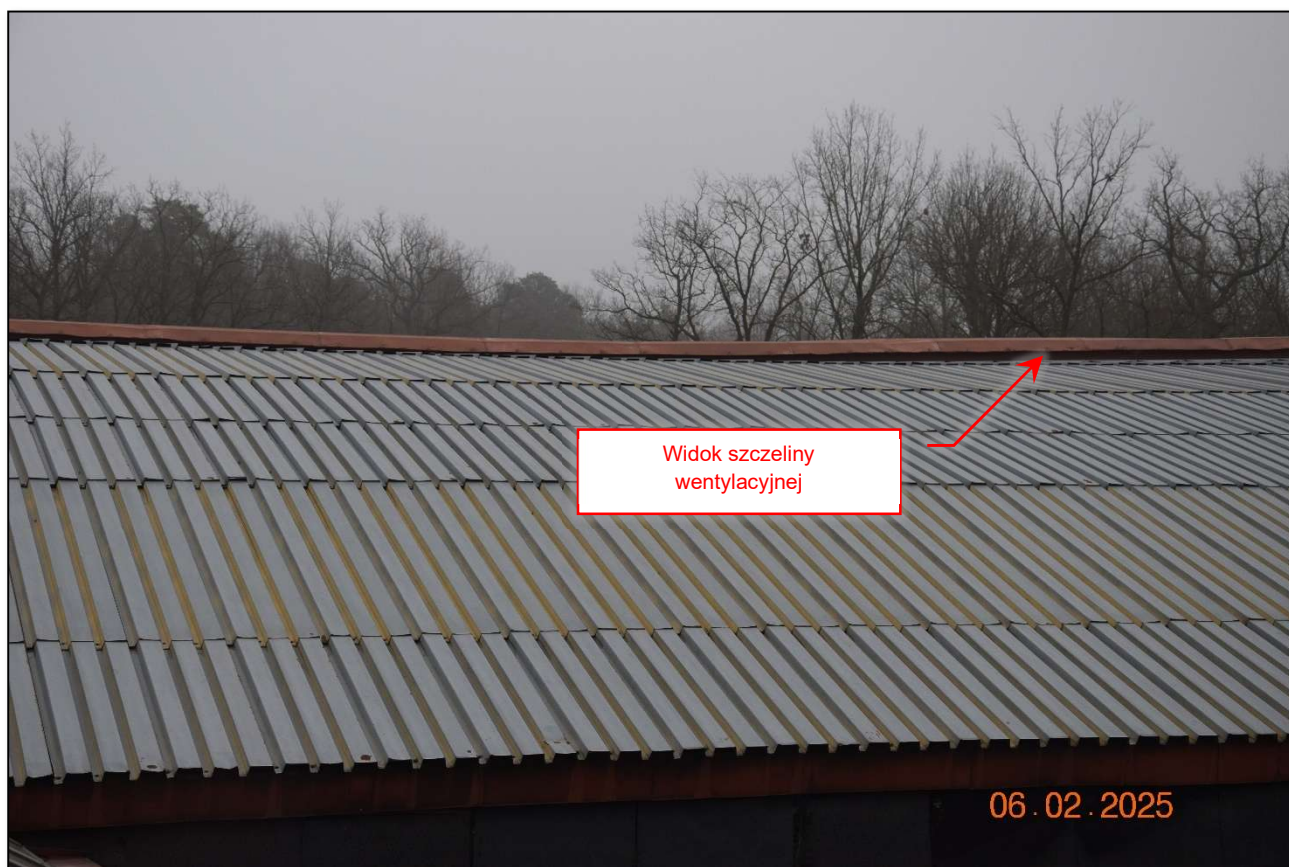
Fot. 127 Detal płaszczyzny dachu. Analiza przyczyny w treści opracowania. (fot. Rafał Fit)
