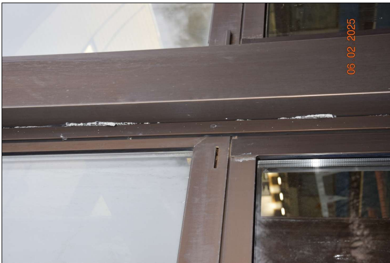
Fot. 155 Detal korozji galwanicznej słupów konstrukcji nośnej fasady aluminiowej. Stan techniczny – zły. (fot. Rafał Fit)
