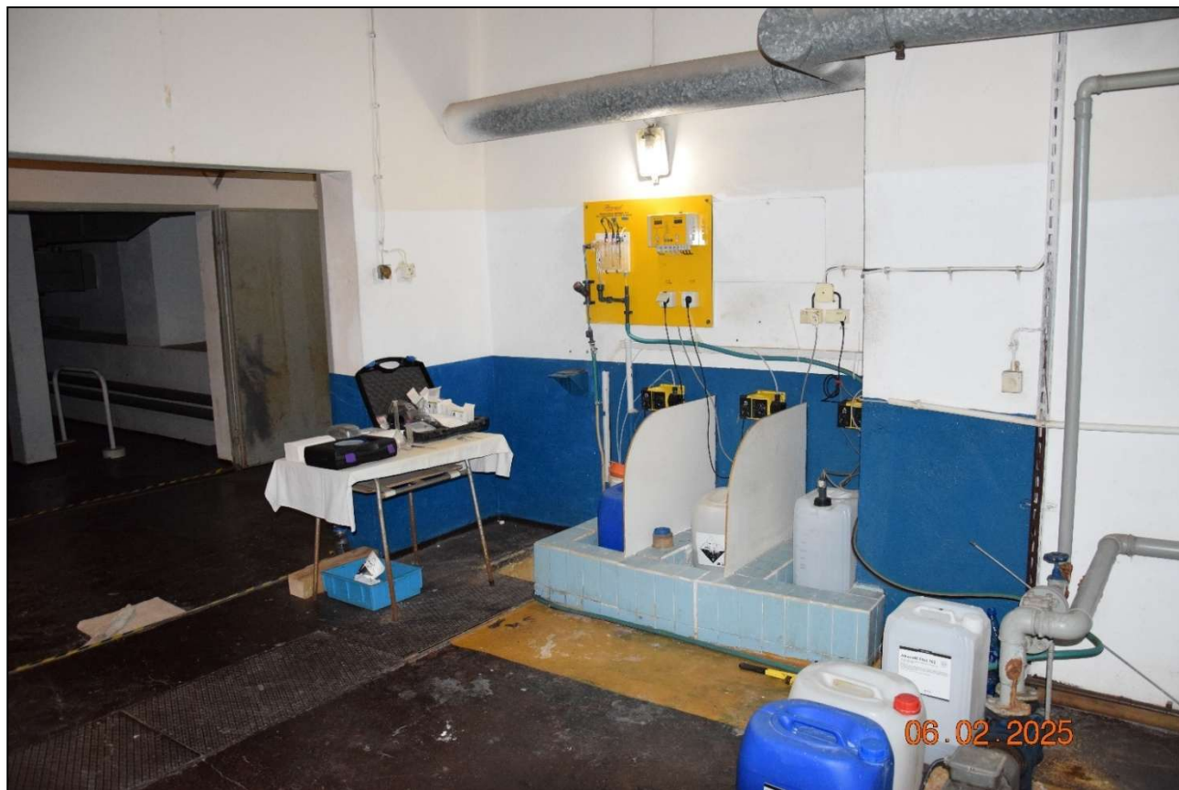
Fot. 191 Instalacja dozowanie chemii basenowej. Wymagane doprowadzenia do aktualnie obowiązujących przepisów higieniczno-sanitarnych m.in. wydzielone pomieszczenie o powierzchniach zmywalnych, oczomyjka itp..(fot. Rafał Fit)
