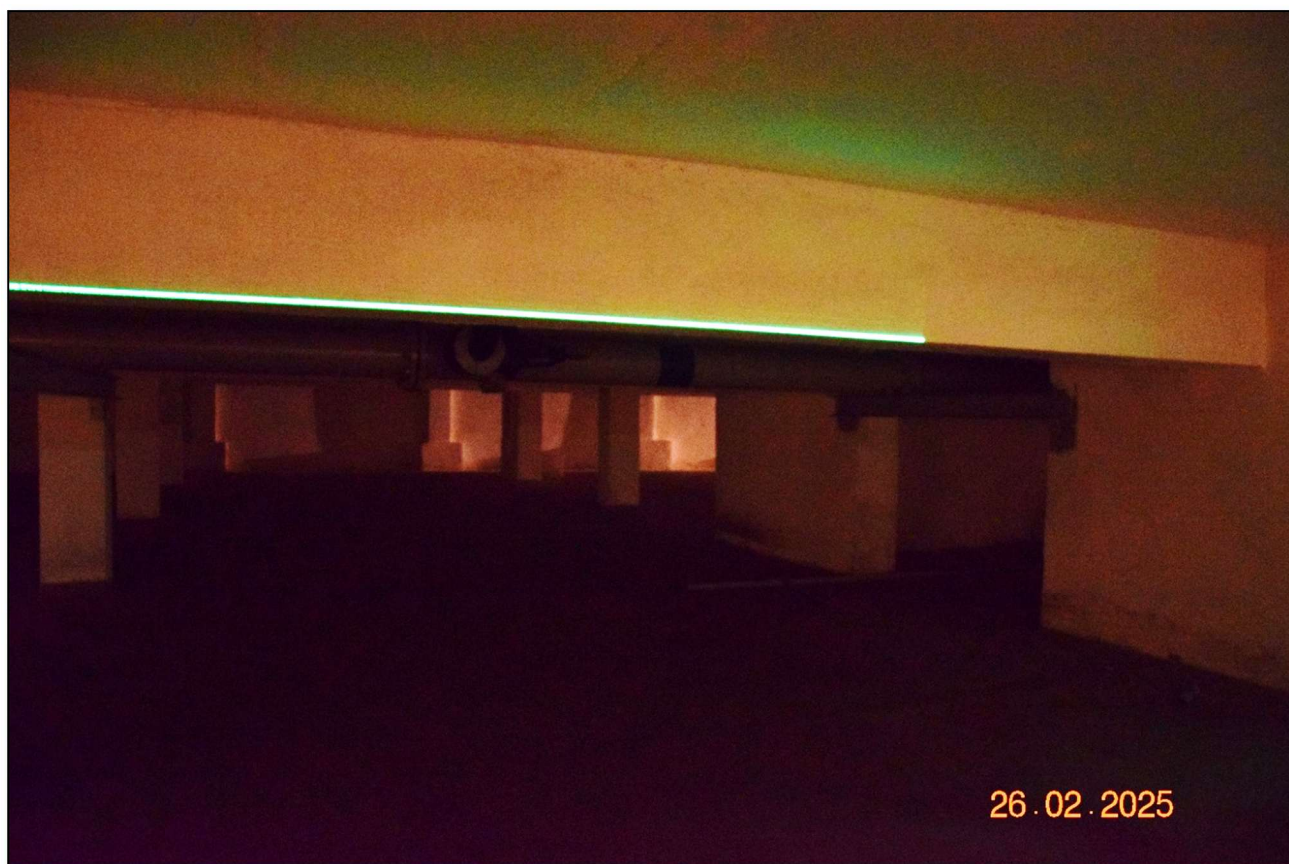
Fot. 22. Inwentaryzacja ugięć i zarysowań belek wieloprzęsłowych – stan techniczny dobry, brak oznak ugięć oraz rys w przęsłach i nad podporami. (fot. Rafał Fit)
