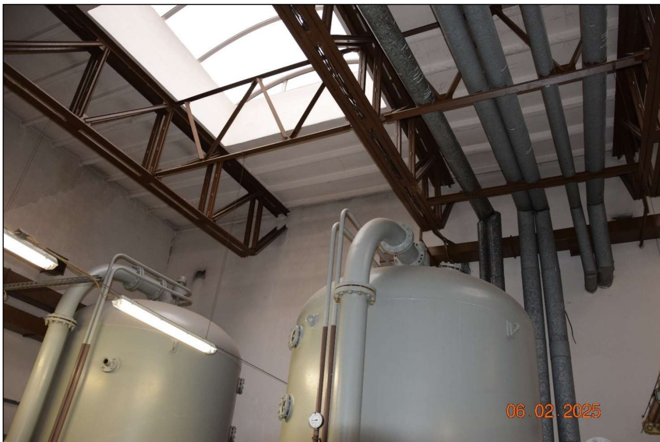
Fot. 196 Widok ogólny zadaszenia dachu. Konstrukcja stalowa przykryta żelbetowymi płytami panwiowymi. Brak widocznych śladów karbonatyzacji betonu (płyty tego typu są bardzo wrażliwe na korozję). (fot. Rafał Fit)
