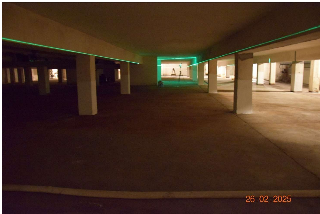
Fot. 23. Inwentaryzacja ugięć i zarysowań belek wieloprzęsłowych – stan techniczny dobry, brak oznak ugięć oraz rys w przęsłach i nad podporami. (fot. Rafał Fit)
