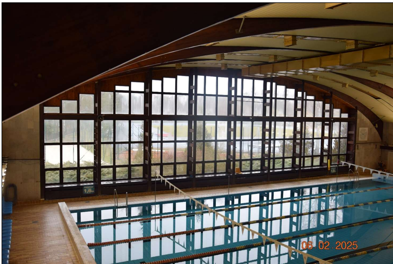
Fot. 156 Widok ogólny konstrukcji fasady aluminiowo – szklanej od strony wewnętrznej. Stan techniczny – zły. (fot. Rafał Fit)
