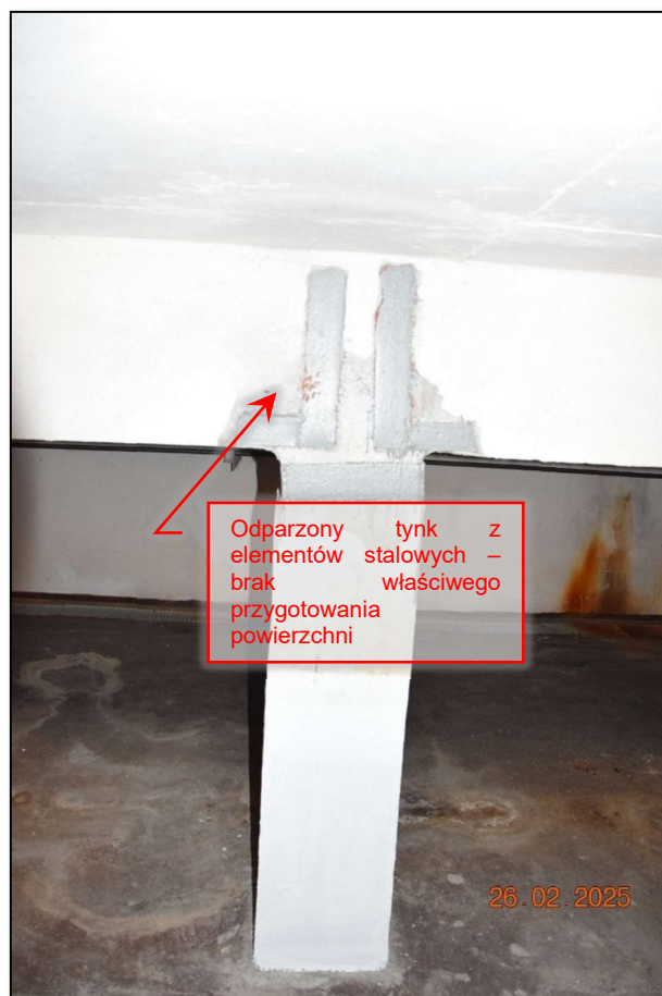
Fot. 226 Inwentaryzacja stanu technicznego konstrukcji nośnej w pomieszczeniu technicznym niecki basenowej – stan techniczny dostateczny. (fot. Rafał Fit)
