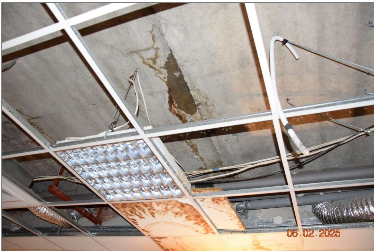
Fot. 251. Widok ogólny stropodachu żelbetowego – stan techniczny dobry. Widoczne lokalne przecieki z poszycia dachu. (fot. Rafał Fit)
