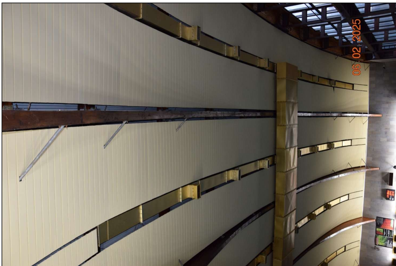
Fot. 179 Analiza wyboczenia i zwichrzenia dźwigarów – nie stwierdzono niepokojących oznak. (fot. Rafał Fit)
