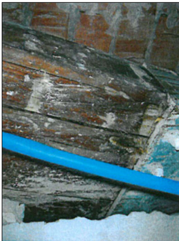
Fot. 85 Widok uszkodzeń drewna w miejscu osadzenia w ostrogach – zdjęcia archiwalne.
