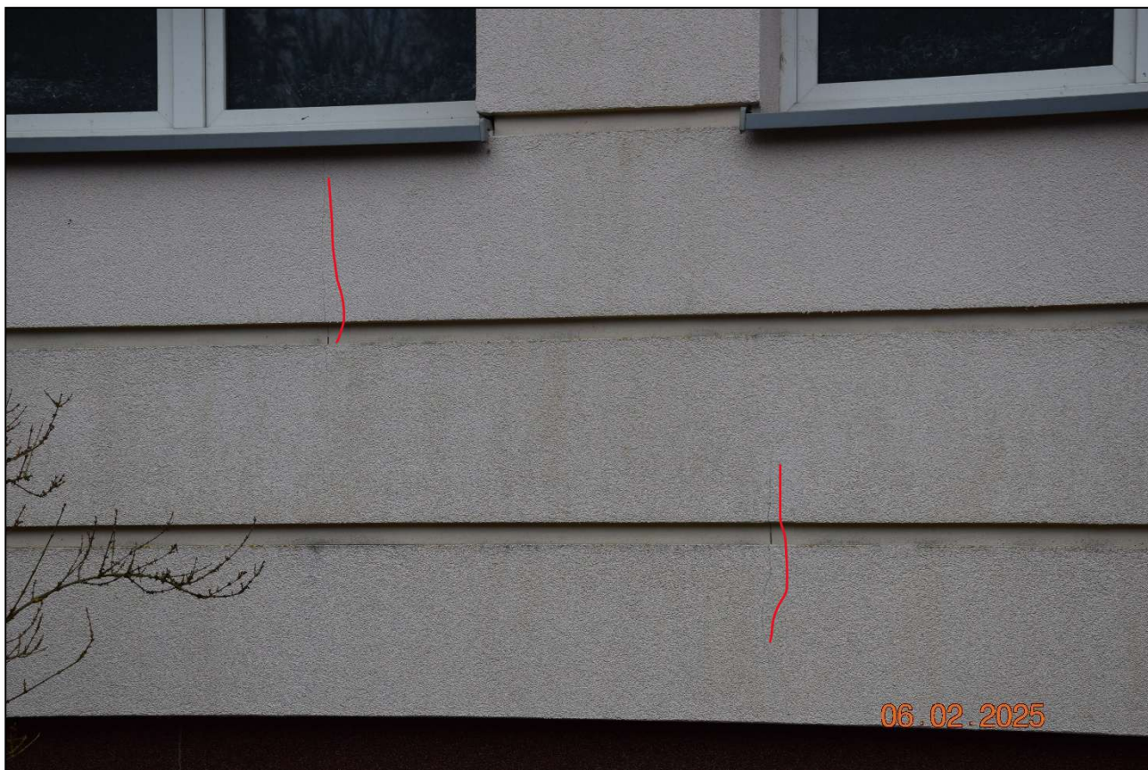
Fot. 138 widok ogólny uszkodzeń elewacji wykonanej w systemie ETICS spowodowane błędami wykonawczymi i okresem eksploatacji. Stan techniczny – dostateczny. (fot. Rafał Fit)
