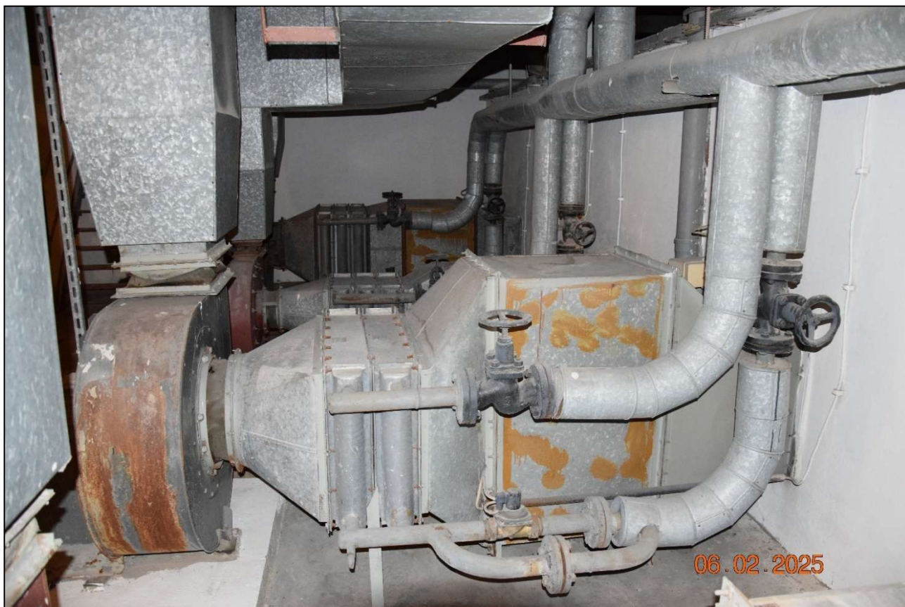
Fot. 210 Instalacje uzdatniania powietrza starego typu. Rozwiązanie mało efektywne. Ślady utlenienia powłoki ochronnej kanałów świadczą o zużyciu eksploatacyjnym tych elementów. (fot. Rafał Fit)
