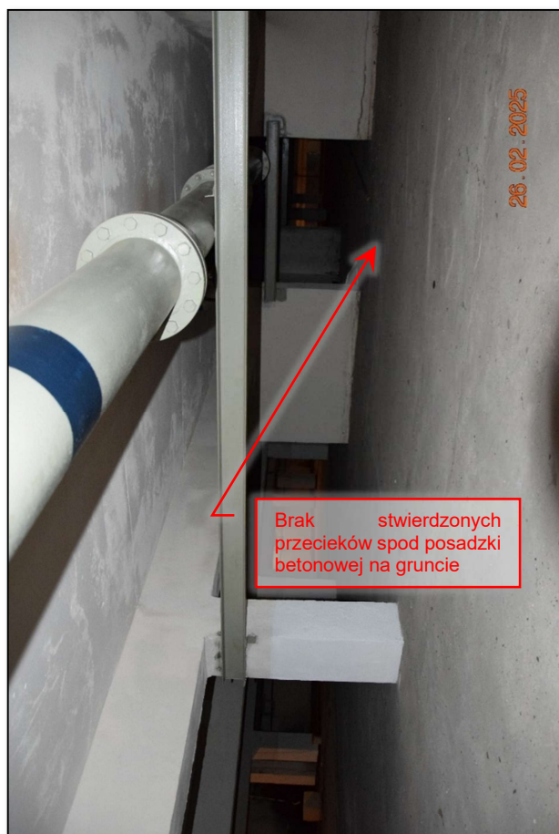
Fot. 223 Inwentaryzacja stanu technicznego konstrukcji nośnej w pomieszczeniu technicznym niecki basenowej – stan techniczny dostateczny. (fot. Rafał Fit)
