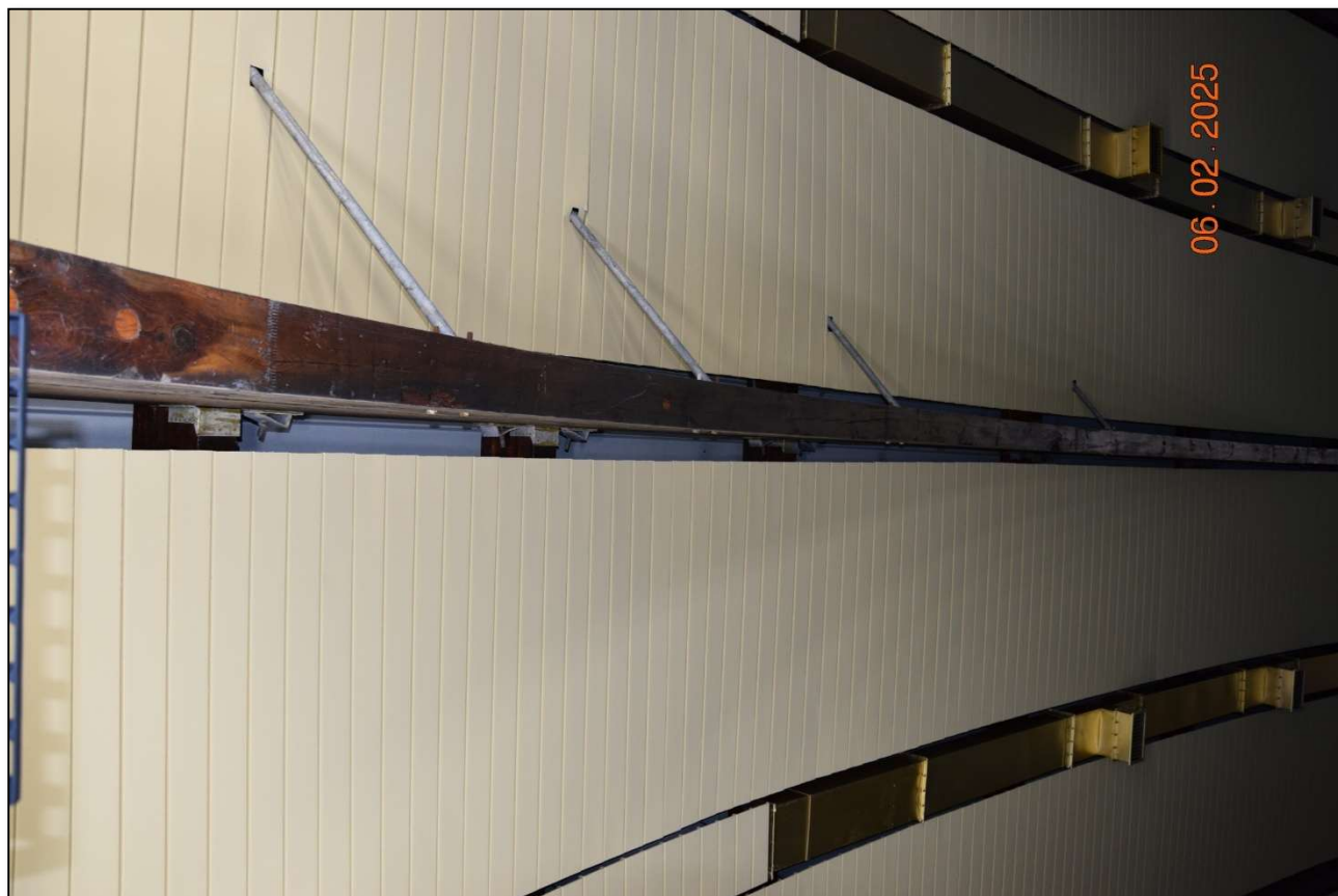
Fot. 176 Analiza wyboczenia i zwichrzenia dźwigarów – nie stwierdzono niepokojących oznak. (fot. Rafał Fit)
