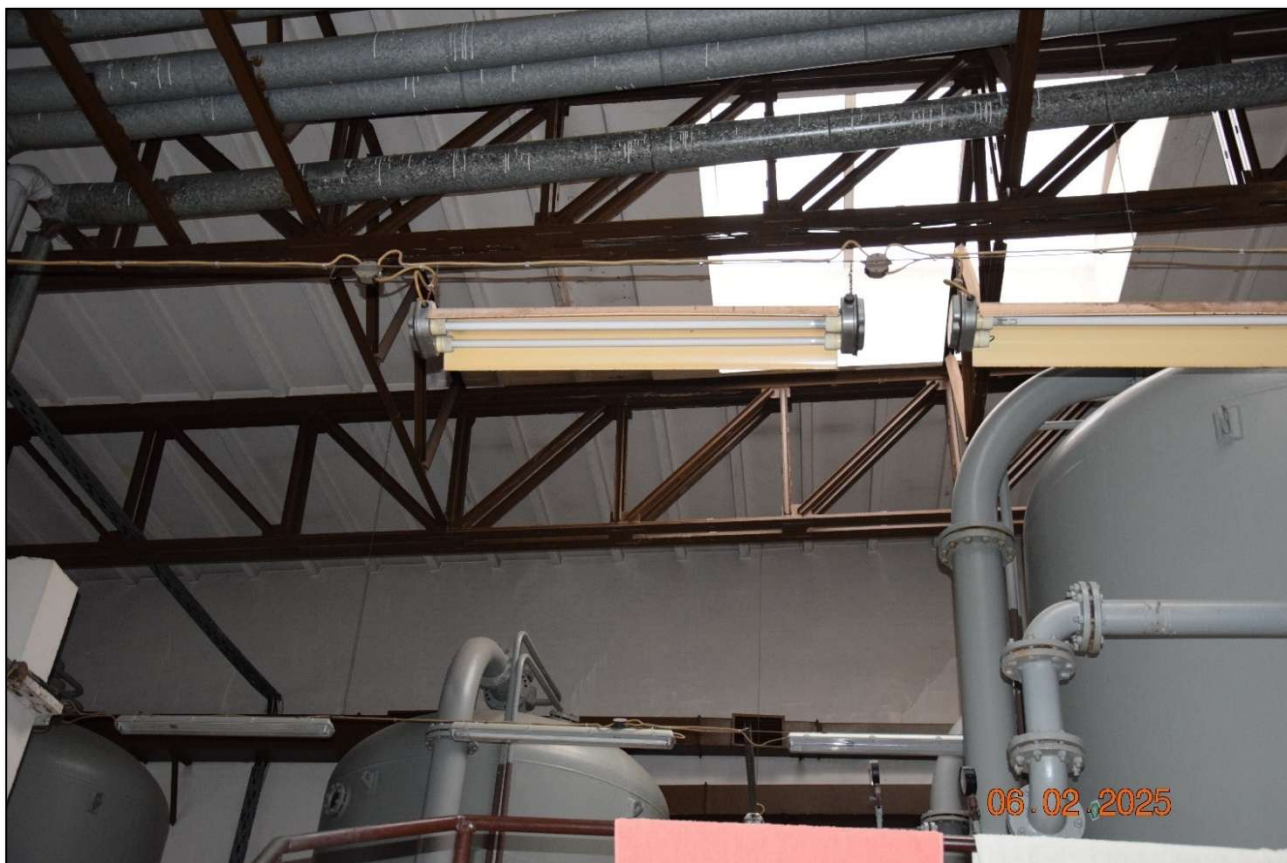
Fot. 194 Widok ogólny zadaszenia dachu. Konstrukcja stalowa przykryta żelbetowymi płytami panwiowymi. Brak widocznych śladów karbonatyzacji betonu (płyty tego typu są bardzo wrażliwe na korozję). (fot. Rafał Fit)
