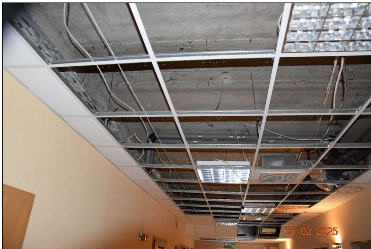
Fot. 249. Widok ogólny stropodachu żelbetowego – stan techniczny dobry. (fot. Rafał Fit)
