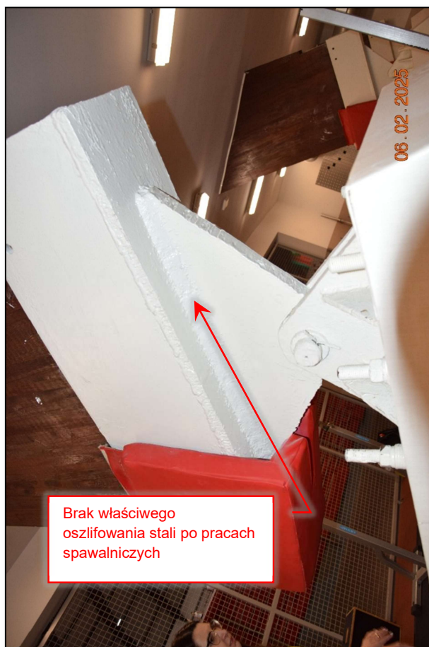
Fot. 94 Analiza stanu technicznego drewnianych dźwigarów i jakości wykonania prac na hali basenowej i sportowej (fot. Rafał Fit).
