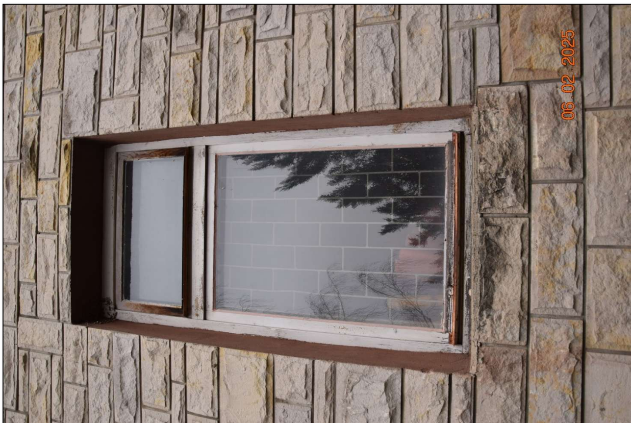
Fot. 148 Stolarka okienna starego typu nie spełnia obecnych parametrów izolacyjności energetycznej. Stan techniczny zły. (fot. Rafał Fit)
