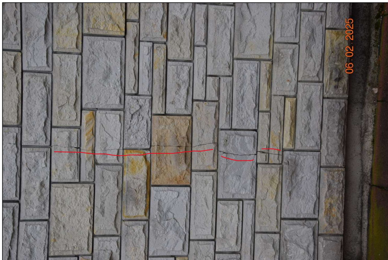
Fot. 136 Widok uszkodzonych okładzin kamiennych spowodowanych korozją mrozową. Brak widocznych pęknięć po drugiej stronie przegrody i ścianach fundamentowych (fot. Rafał Fit)
