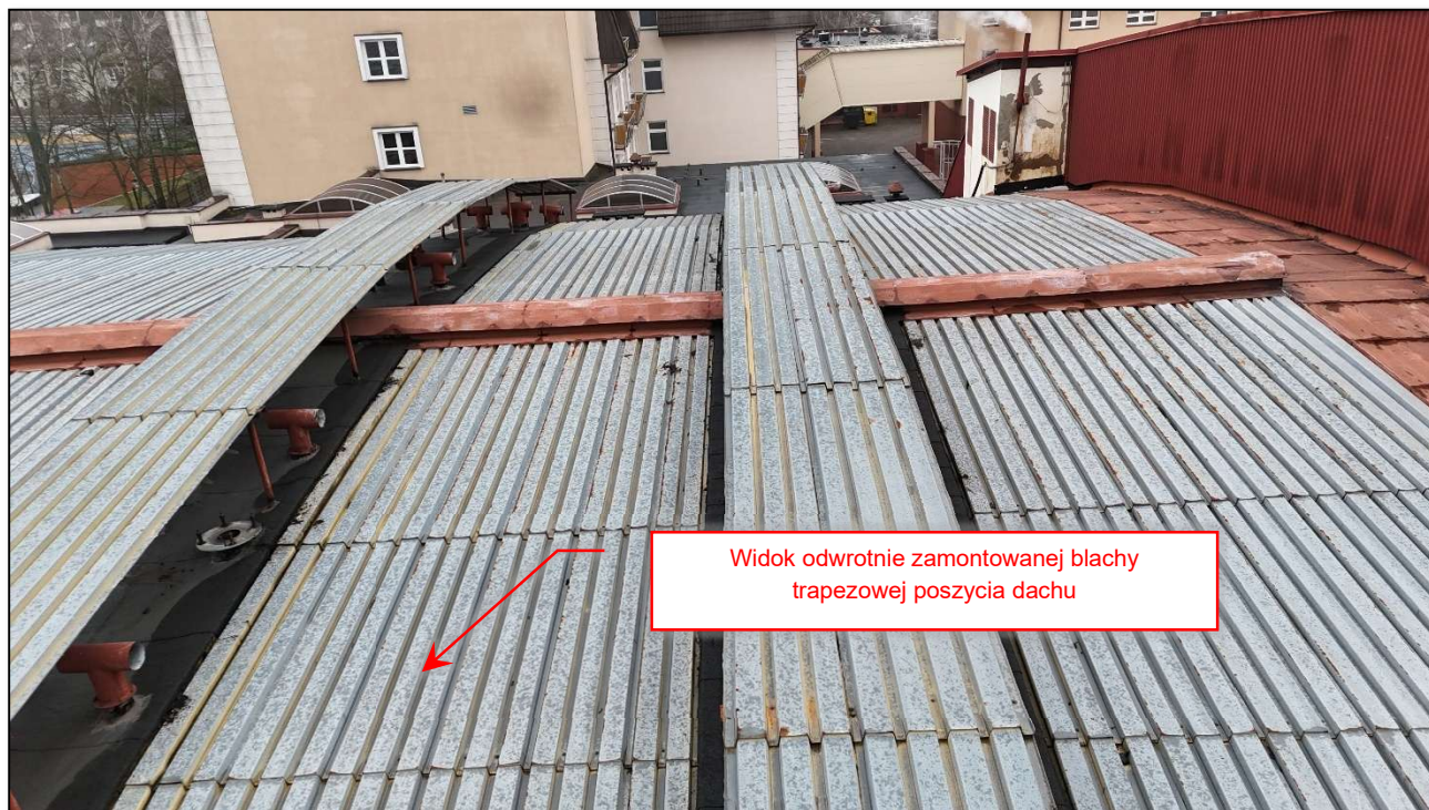
Fot. 120 Widok niewłaściwie zamontowanej blachy trapezowej stanowiącej poszycie dachu – przetłoczenia węższe powinny być po stronie wierzchniej przez co blacha ma większą wytrzymałość punktową. (fot. Rafał Fit)
