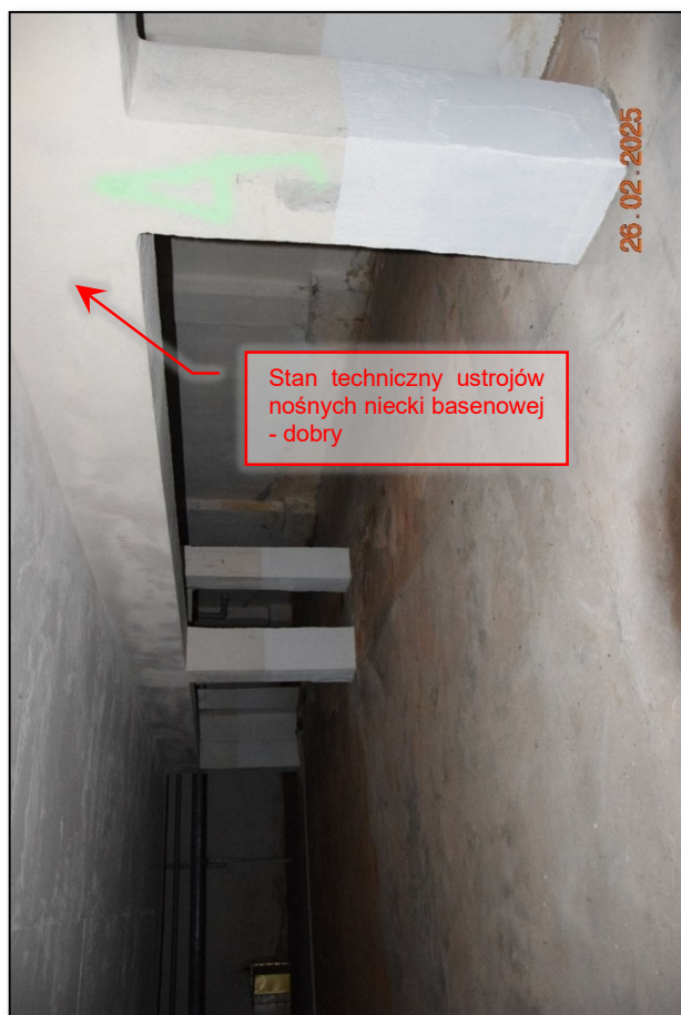
Fot. 220 Inwentaryzacja stanu technicznego konstrukcji nośnej w pomieszczeniu technicznym niecki basenowej – stan techniczny dostateczny. (fot. Rafał Fit)
