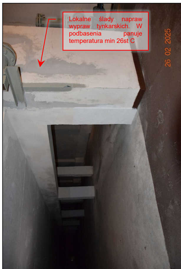
Fot. 219 Inwentaryzacja stanu technicznego konstrukcji nośnej w pomieszczeniu technicznym niecki basenowej – stan techniczny dostateczny. (fot. Rafał Fit)
