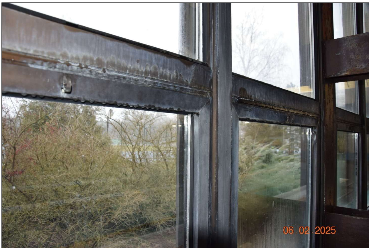
Fot. 163 Detal uszkodzonych pakietów szybowych fasady aluminiowo – szklanej. Widok od strony wewnętrznej. Stan techniczny – zły. (fot. Rafał Fit)
