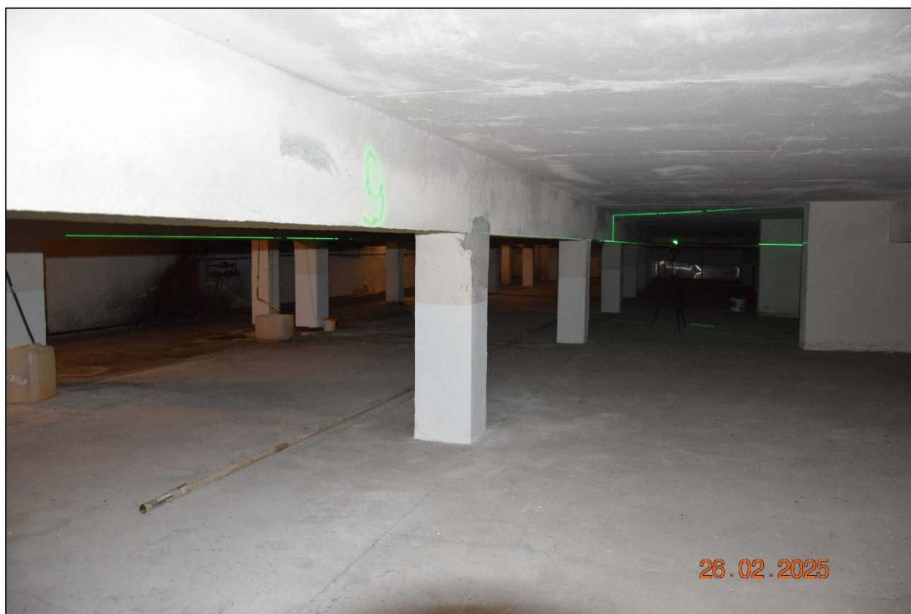
Fot. 20. Inwentaryzacja ugięć i zarysowań belek wieloprzęsłowych – stan techniczny dobry, brak oznak ugięć oraz rys w przęsłach i nad podporami. (fot. Rafał Fit)
