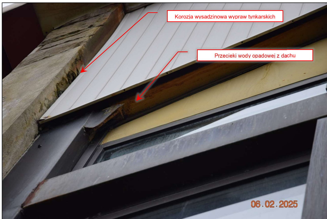
Fot. 150 Detal wycieków wody spod elementów fasady. Stan techniczny – zły. (fot. Rafał Fit)
