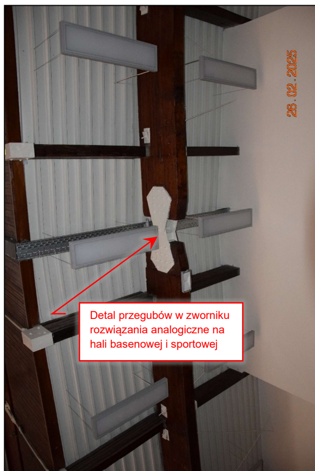
Fot. 91 Analiza stanu technicznego drewnianych dźwigarów i jakości wykonania prac na hali basenowej i sportowej (fot. Rafał Fit).
