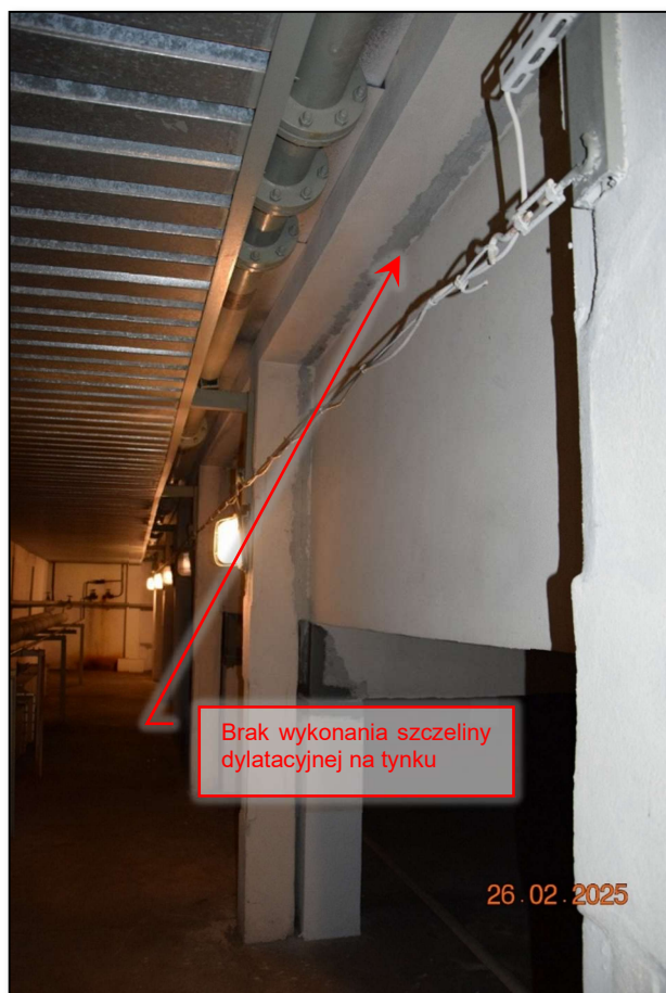
Fot. 228 Inwentaryzacja stanu technicznego konstrukcji nośnej w pomieszczeniu technicznym niecki basenowej – stan techniczny dostateczny. (fot. Rafał Fit)
