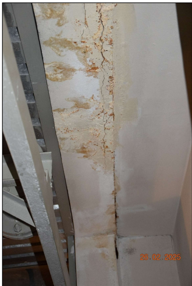
Fot. 57. Inwentaryzacja destrukcji elementów żelbetowych spowodowana oddziaływaniem wody basenowej (fot. Rafał Fit)
