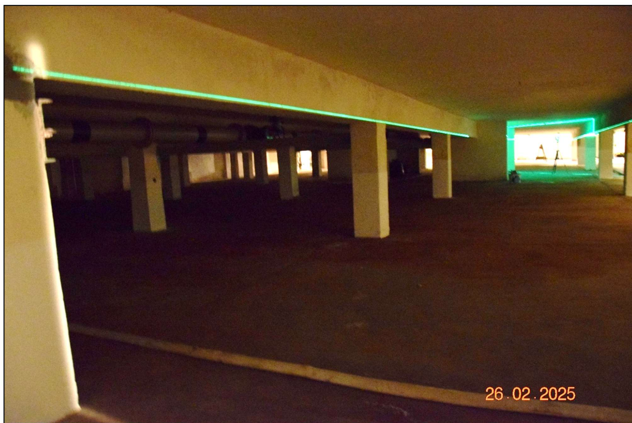
Fot. 24. Inwentaryzacja ugięć i zarysowań belek wieloprzęsłowych – stan techniczny dobry, brak oznak ugięć oraz rys w przęsłach i nad podporami. (fot. Rafał Fit)
