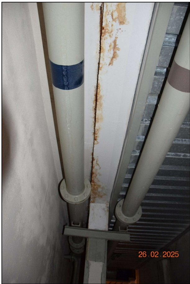
Fot. 56. Inwentaryzacja destrukcji elementów żelbetowych spowodowana oddziaływaniem wody basenowej (fot. Rafał Fit)
