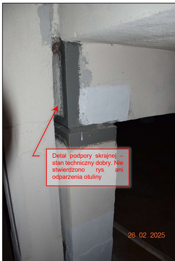
Fot. 222 Inwentaryzacja stanu technicznego konstrukcji nośnej w pomieszczeniu technicznym niecki basenowej – stan techniczny dostateczny. (fot. Rafał Fit)
