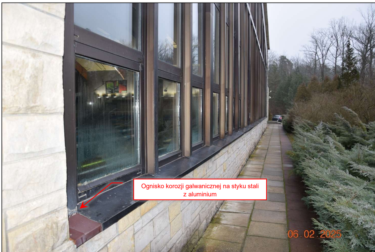
Fot. 149 Widok niewłaściwie wykonanych obróbek blacharskich. Zastosowano różne typy materiałów (aluminium, stal) przez co rozwija się korozja galwaniczna. (fot. Rafał Fit)
