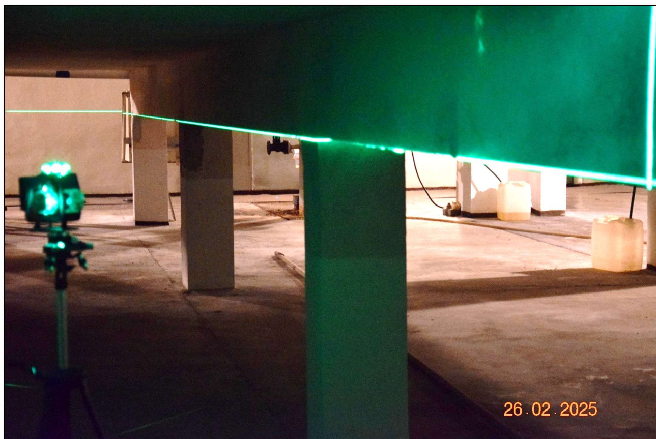
Fot. 21. Inwentaryzacja ugięć i zarysowań belek wieloprzęsłowych – stan techniczny dobry, brak oznak ugięć oraz rys w przęsłach i nad podporami. (fot. Rafał Fit)
