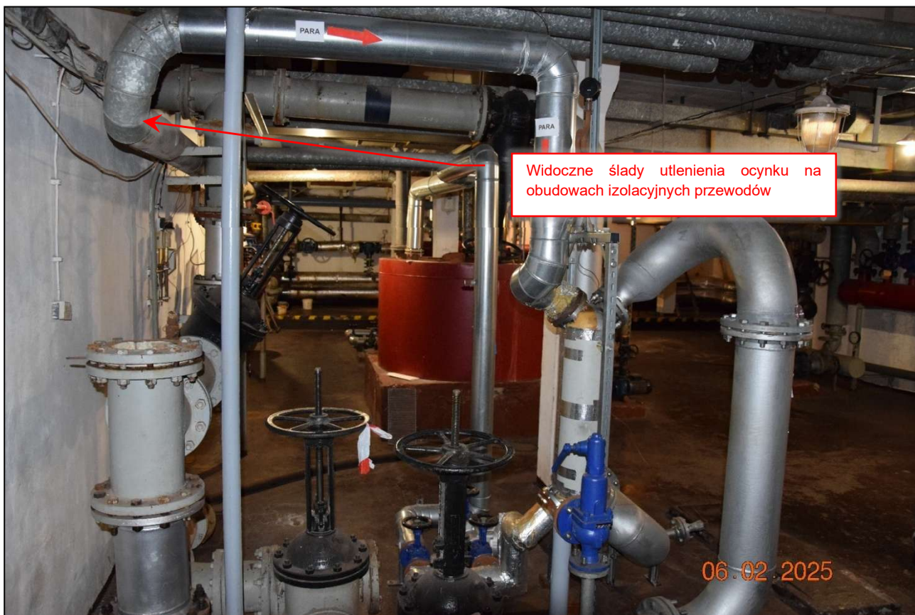
Fot. 201 Widok ogólny pomieszczenia technologicznego pompowni basenowej. Stan techniczny - dostateczny. (fot. Rafał Fit)
