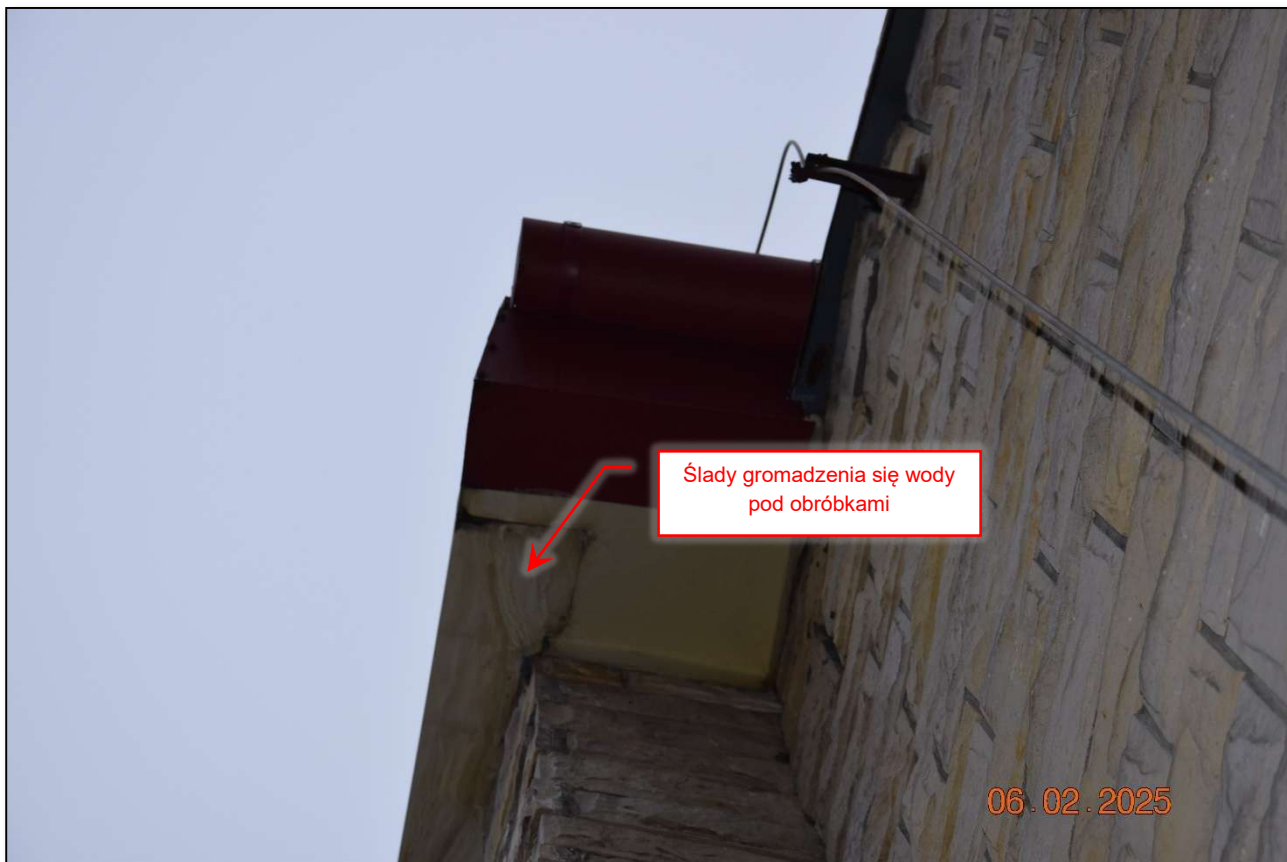
Fot. 133 Detal obróbek frontowych. Widoczne ślady korozji oraz nieszczelności połączeń. (fot. Rafał Fit)
