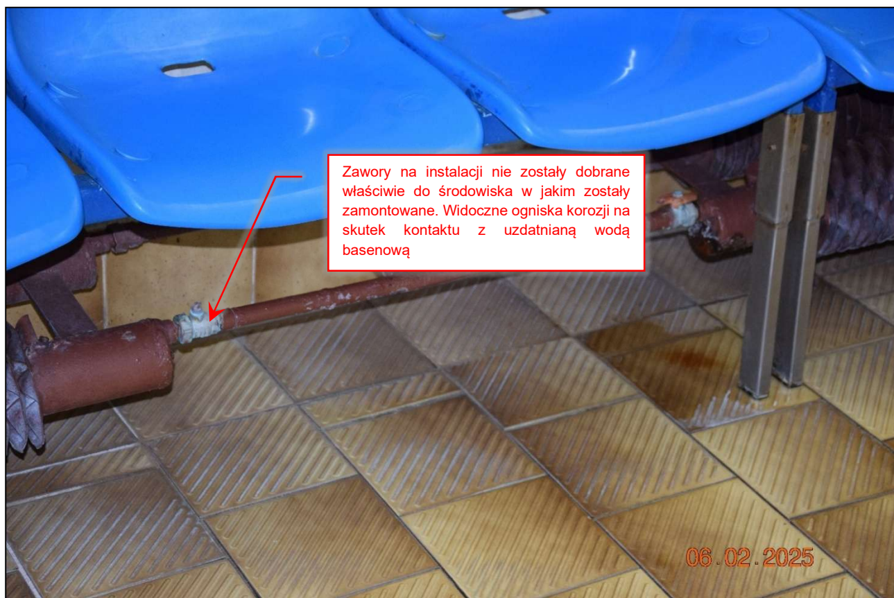
Fot. 186 Instalacje ogrzewcze zainstalowane na hali basenowej nie spełniają obecnych standardów efektywności energetycznej. (fot. Rafał Fit)
