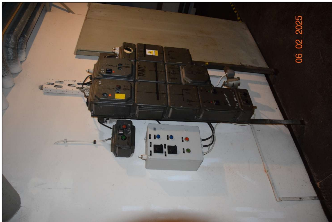
Fot. 190 Wewnętrzne rozdzielnie elektryczne rozdziału mocy starego typu. Zalecana wymiana na nowe zunifikowane systemowe szafowe z możliwością instalacji aparatów bezpiecznikowych i różnicowoprądowych. (fot. Rafał Fit)
