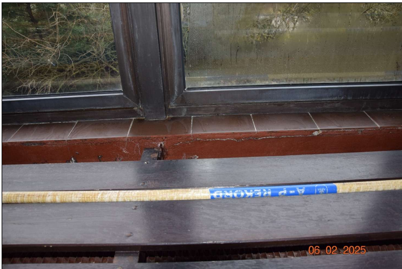
Fot. 162 Detal uszkodzonych pakietów szybowych fasady aluminiowo – szklanej. Widok od strony wewnętrznej. Stan techniczny – zły. (fot. Rafał Fit)
