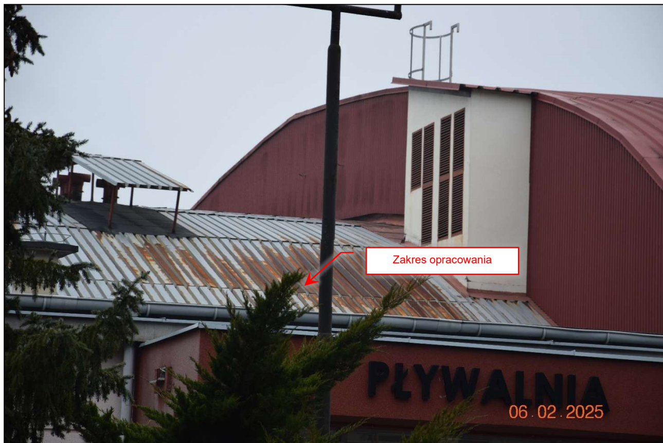
Fot. 124 Widok korozji poszycia dachu nad wejściem głównym. (fot. Rafał Fit)
