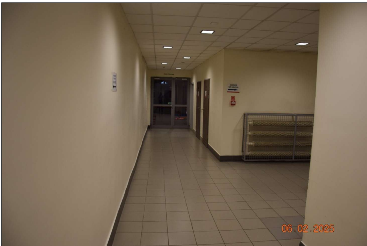
Fot. 243. Widok ogólny posadzek ceramicznych w korytarzach głównych. Stan techniczny – dostateczny. Lokalnie stwierdzono odspojone płytki do podłoża które należy poprawić w ramach remontów doraźnych. (fot. Rafał Fit)
