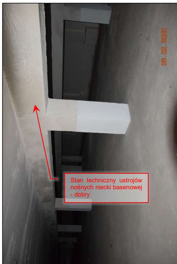
Fot. 221 Inwentaryzacja stanu technicznego konstrukcji nośnej w pomieszczeniu technicznym niecki basenowej – stan techniczny dostateczny. (fot. Rafał Fit)
