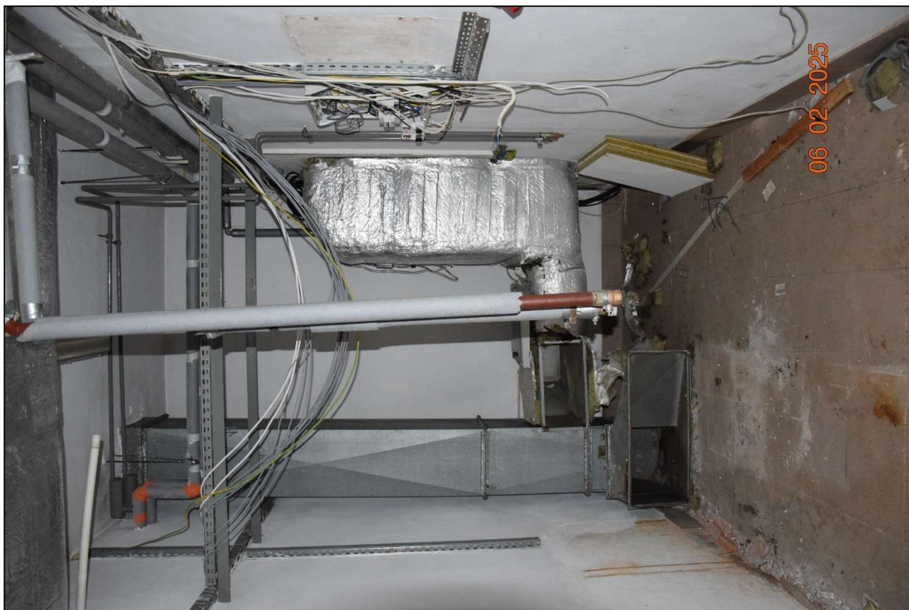
Fot. 252 Pomieszczenia techniczne w części odnowy biologicznej wyłączone z użytkowania. Stan techniczny instalacji - zły. (fot. Rafał Fit)
