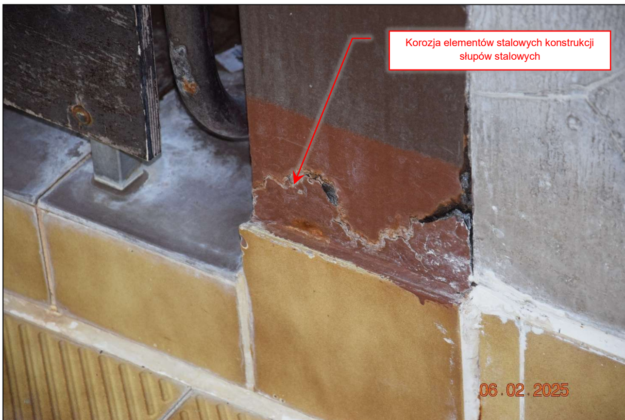
Fot. 157 Widok skorodowanych elementów słupów stalowych wielogłęziowych. (fot. Rafał Fit)
