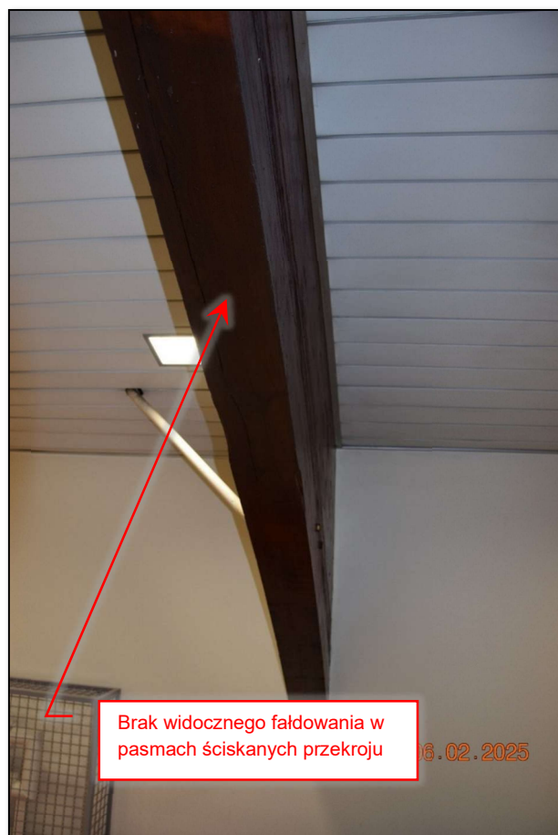
Fot. 87 Analiza stanu technicznego drewnianych dźwigarów hali basenowej (fot. Rafał Fit).
