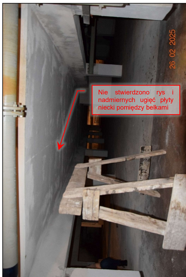
Fot. 224 Inwentaryzacja stanu technicznego konstrukcji nośnej w pomieszczeniu technicznym niecki basenowej – stan techniczny dostateczny. (fot. Rafał Fit)
