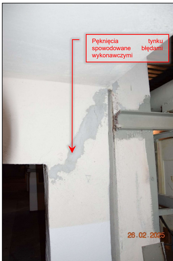
Fot. 224 Inwentaryzacja stanu technicznego konstrukcji nośnej w pomieszczeniu technicznym niecki basenowej – stan techniczny dostateczny. (fot. Rafał Fit)
