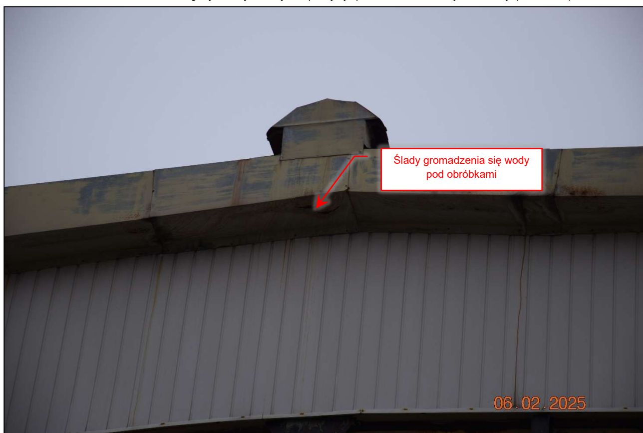
Fot. 131 Detal obróbek frontowych. Widoczne ślady korozji oraz nieszczelności połączeń. (fot. Rafał Fit)
