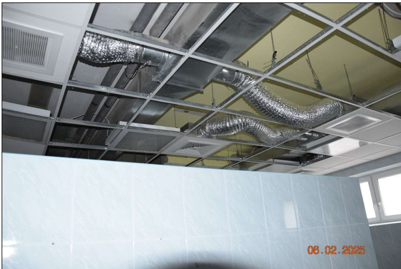
Fot. 254. Kanaly ocynkowane mechanicznej instalacji wentylacyjnej w większości pomieszczeń – stan techniczny dobry. (fot. Rafał Fit)
