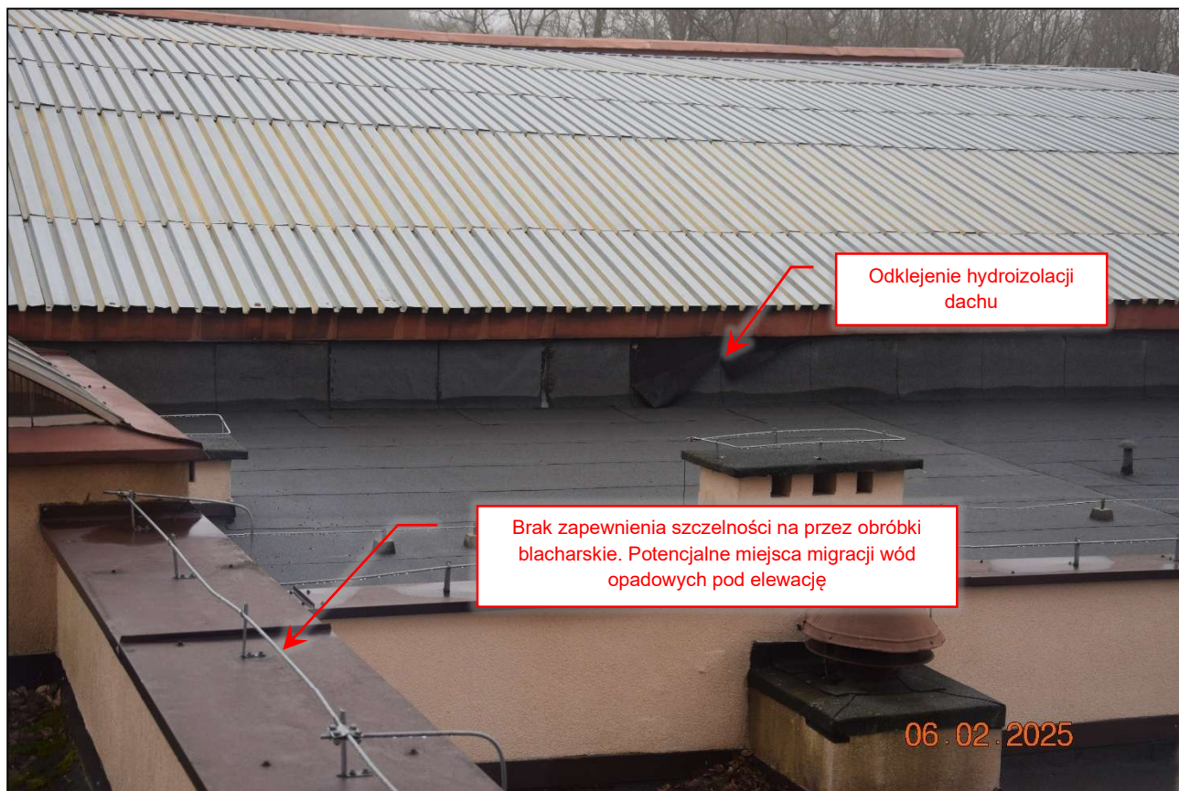
Fot. 125 Widok ogólny poszycia dachów płaskich. Widoczne uszkodzenie pionowych wywinięć hydroizolacji. (fot. Rafał Fit)
