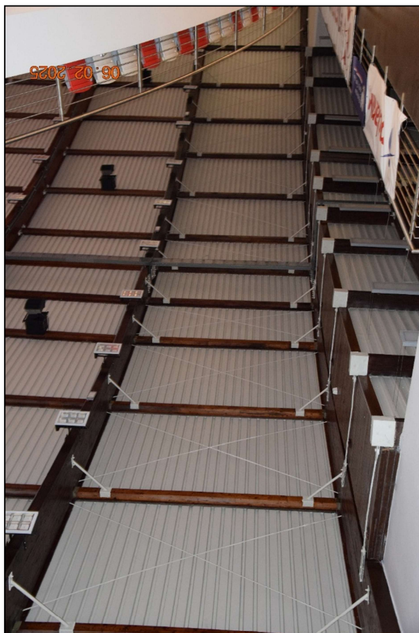
Fot. 95 Analiza stanu technicznego drewnianych dźwigarów i jakości wykonania prac na hali basenowej i sportowej (fot. Rafał Fit).
