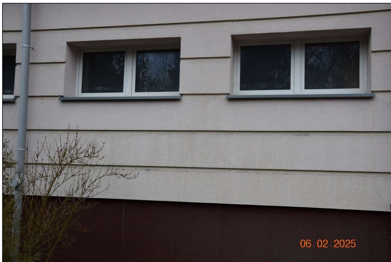
Fot. 164 Stolarka okienna z PVC wyposażona w pakiety szybowe jednokomorowe. Stan użytkowy dobry. Nie spełniają obecnych warunków dotyczących izolacyjności energetycznej. (fot. Rafał Fit)
