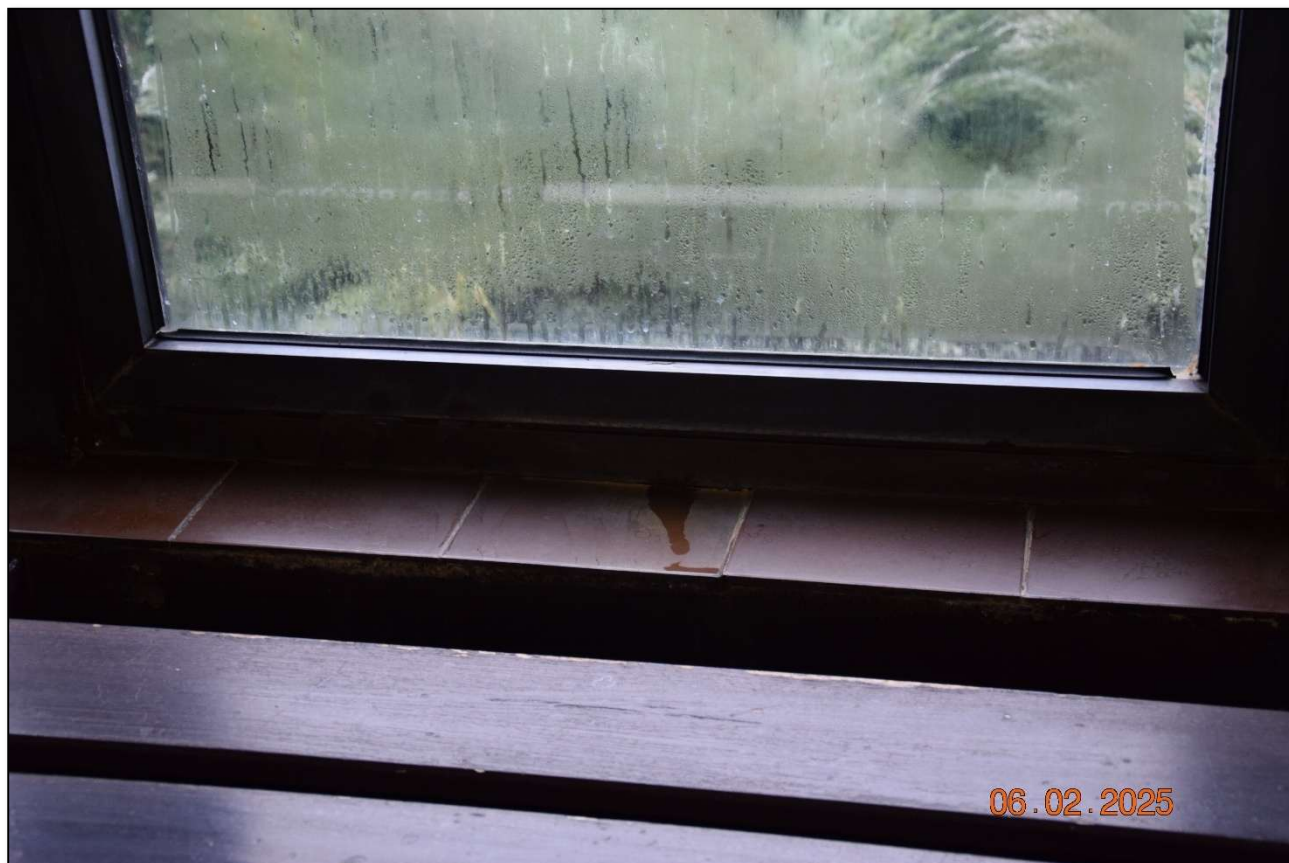
Fot. 160 Detal uszkodzonych pakietów szybowych fasady aluminiowo – szklanej. Widok od strony wewnętrznej. Stan techniczny – zły. Wilgoć występująca pomiędzy szkleniem świadczy o ulotnieniu gazów obojętnych. (fot. Rafał Fit)
