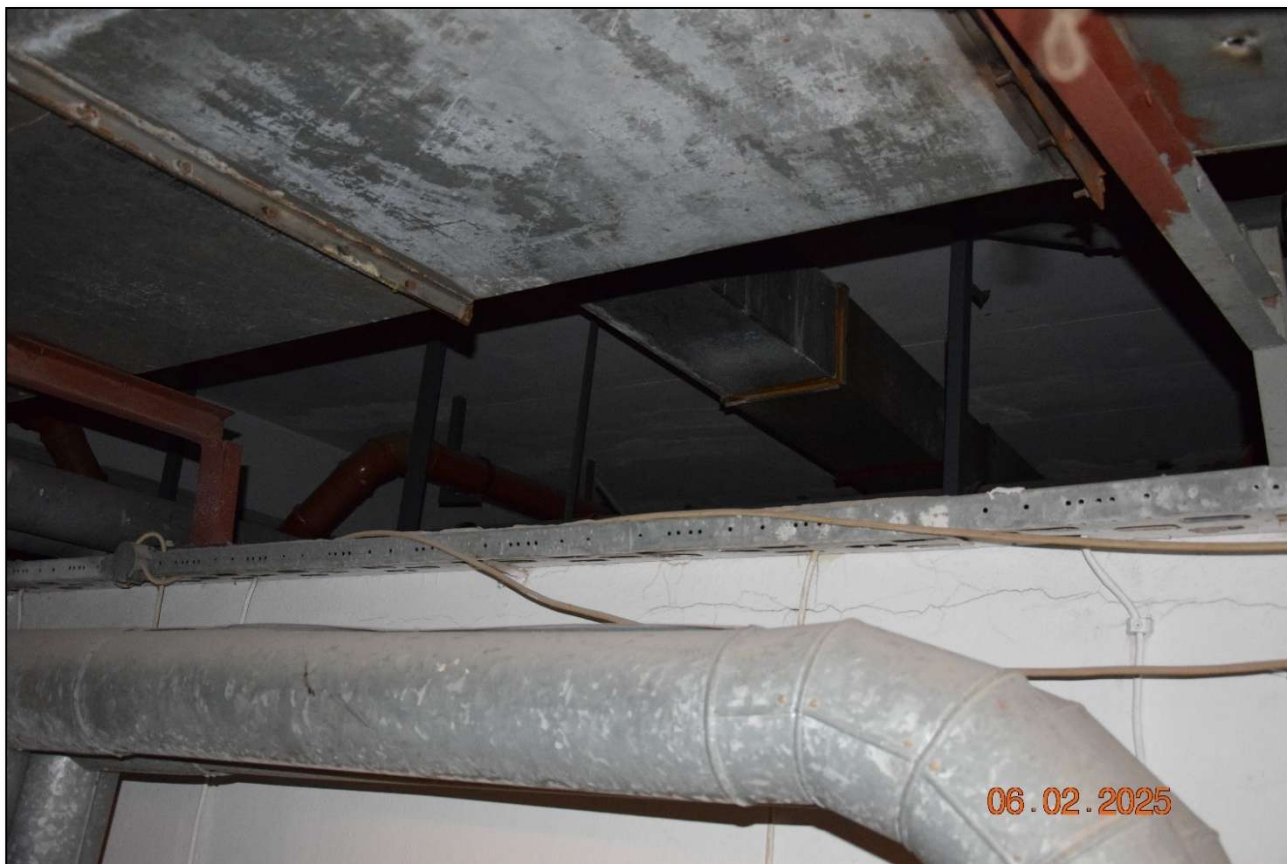
Fot. 209 Instalacje uzdatniania powietrza starego typu. Rozwiązanie mało efektywne. Ślady utlenienia powłoki ochronnej kanałów świadczą o zużyciu eksploatacyjnym tych elementów. (fot. Rafał Fit)
