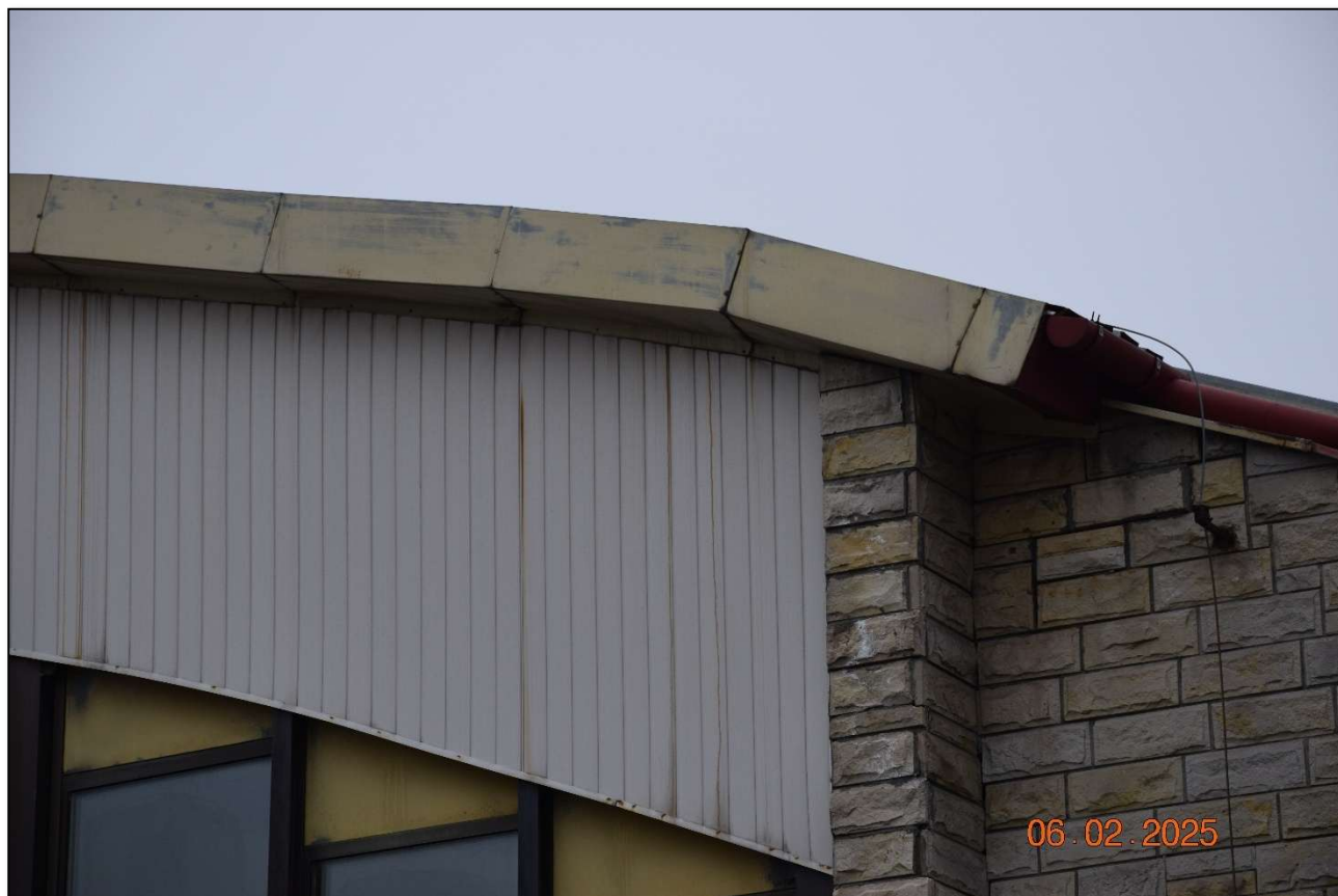
Fot. 144 Widok braku zapewnienia szczelności zamknięcia górnej fasady. Stan techniczny zły. (fot. Rafał Fit)
