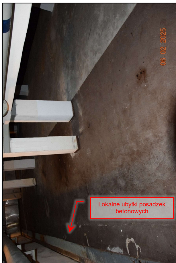
Fot. 214 Inwentaryzacja stanu technicznego konstrukcji nośnej w pomieszczeniu technicznym niecki basenowej – stan techniczny dostateczny. (fot. Rafał Fit)
