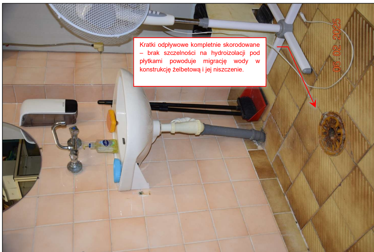
Fot. 187 Okładziny ścienne jak i podłogowe stan techniczny zły – uległy naturalnemu zużyciu na skutek eksploatacji. (fot. Rafał Fit)
