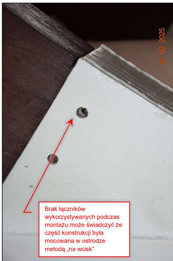
Fot. 91 Analiza stanu technicznego drewnianych dźwigarów i jakości wykonania prac na hali basenowej i sportowej (fot. Rafał Fit).
