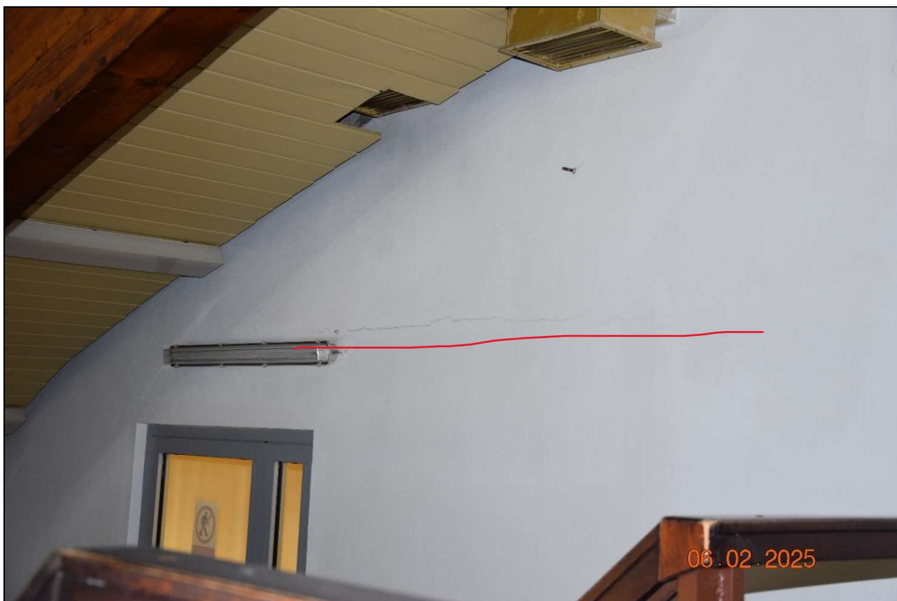
Fot. 235. Pęknięcia na wewnętrznych ścianach działowych spowodowane zmianą sposobu użytkowania korytarzy – wprowadzono urządzenia do ćwiczeń które generują obciążenia dynamiczne. Brak wpływu na bezpieczeństwo konstrukcji. (fot. Rafał Fit)
