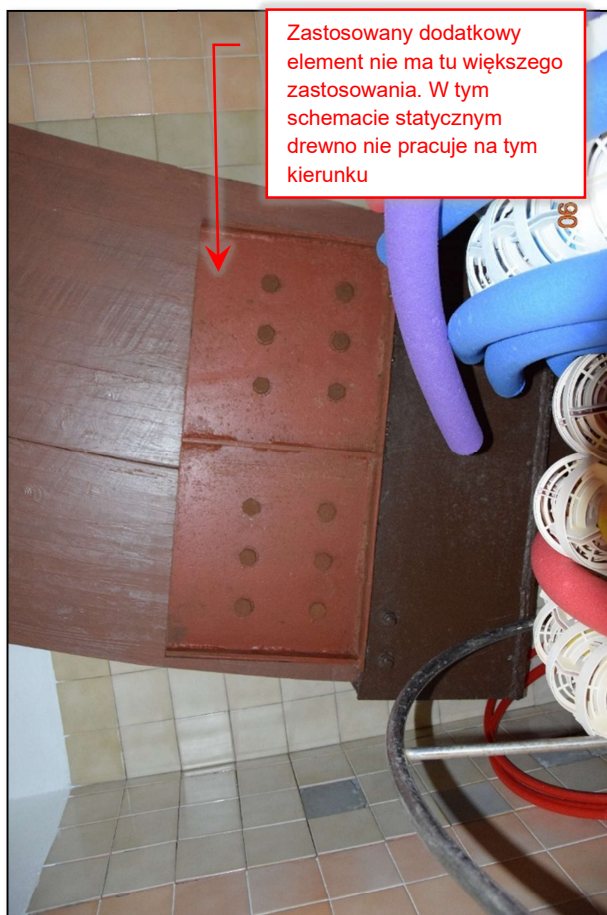
Fot. 88 Analiza stanu technicznego drewnianych dźwigarów hali basenowej (fot. Rafał Fit).
