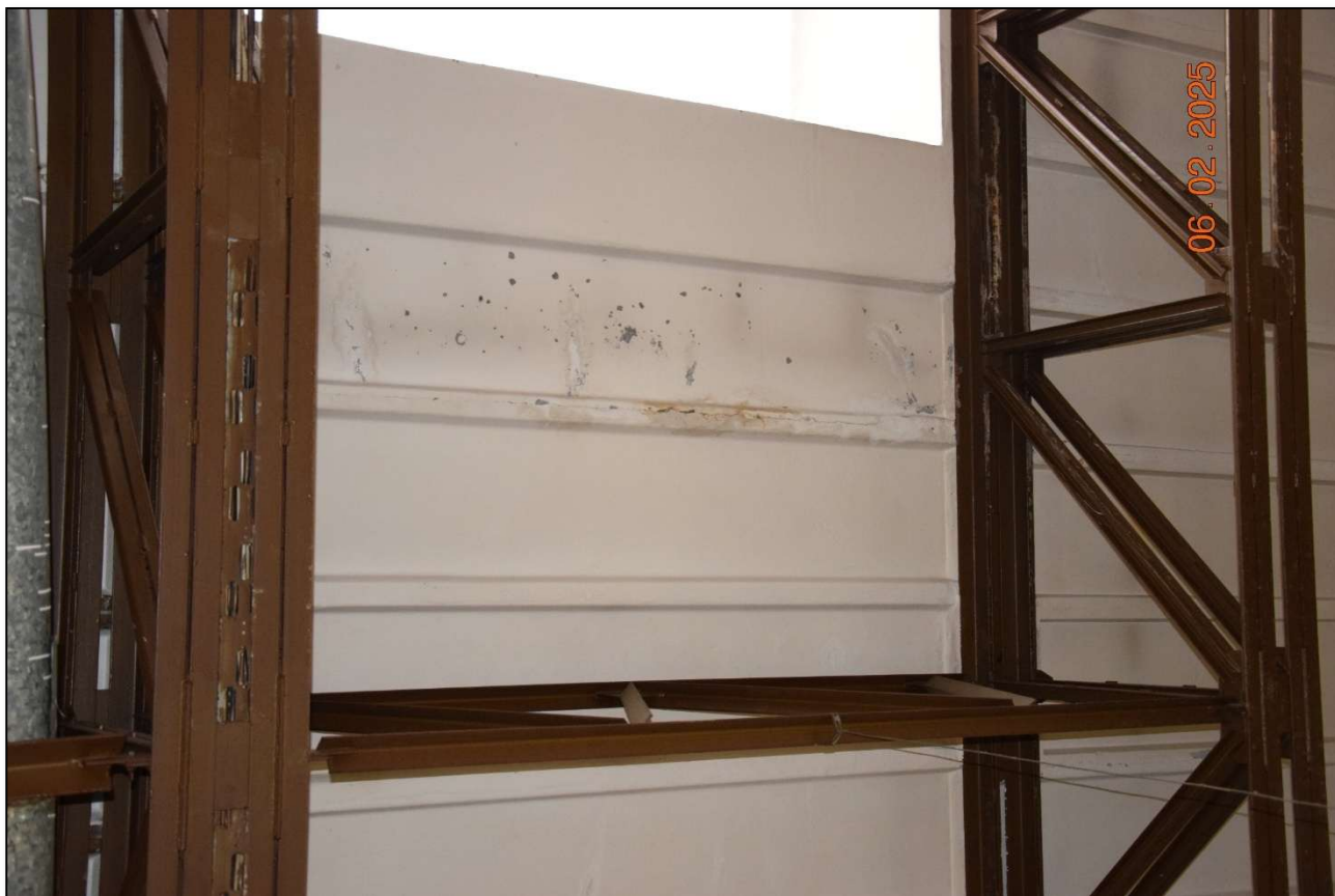
Fot. 197 Widok ogólny zadaszenia dachu. Konstrukcja stalowa przykryta żelbetowymi płytami panwiowymi. Brak widocznych śladów karbonatyzacji betonu (płyty tego typu są bardzo wrażliwe na korozję). (fot. Rafał Fit)
