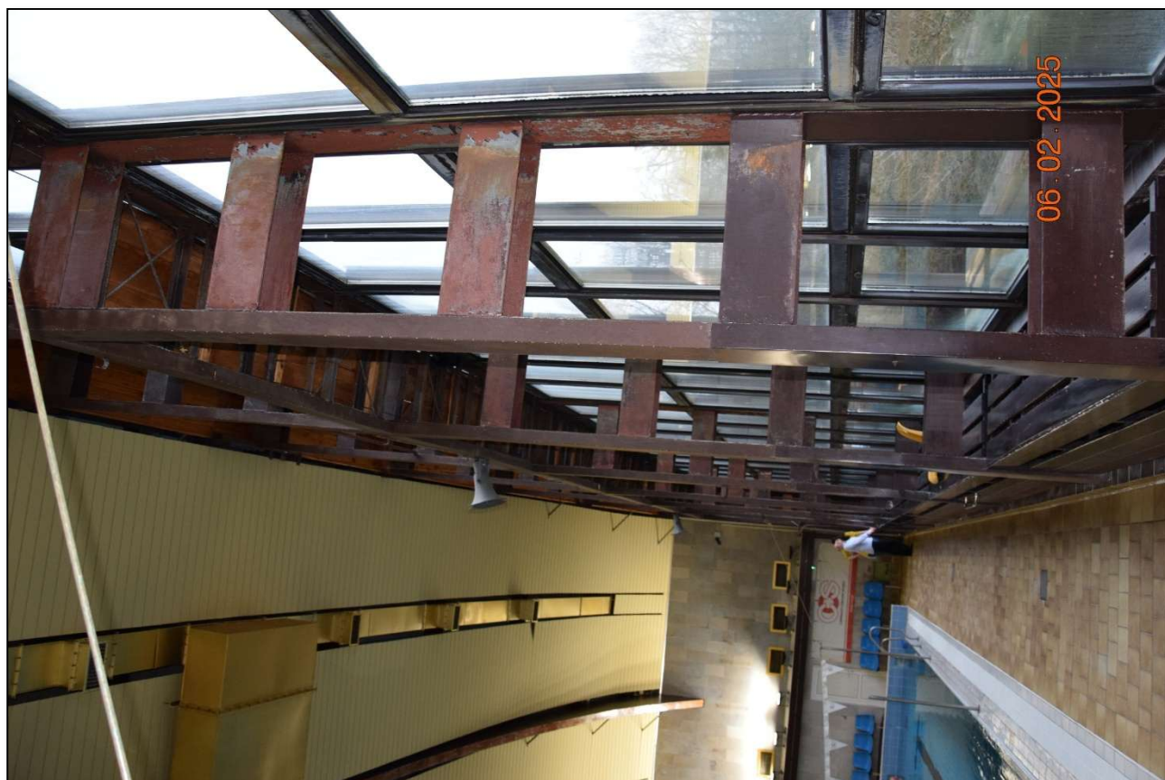
Fot. 161 Widok ogólny konstrukcji stalowej ściany szczytowej. Stan techniczny – zły. Utrata powłok malarskich przyspieszy proces korozji. (fot. Rafał Fit)
