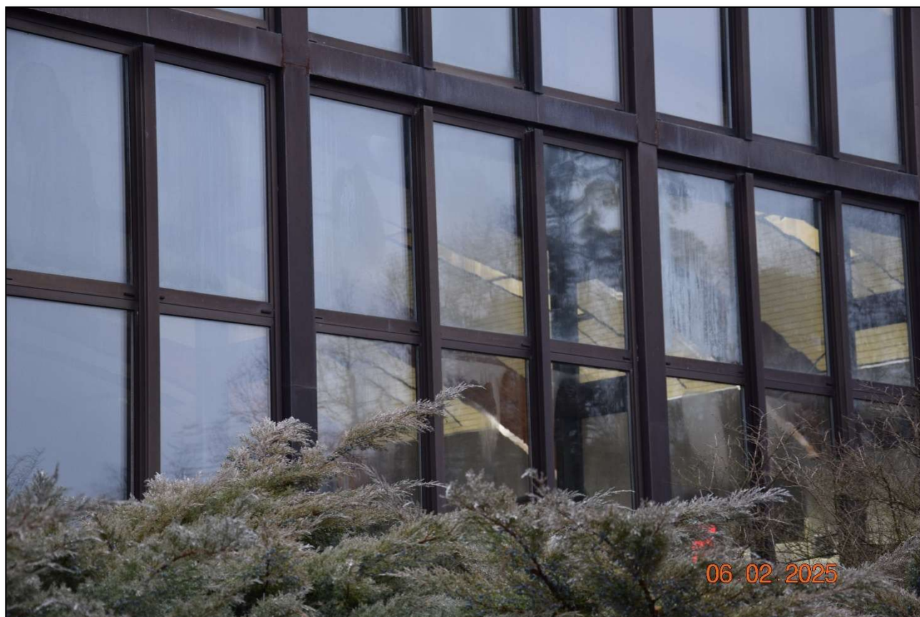
Fot. 147 Widoczne ślady gromadzenia się pary wodnej na wewnętrznej stronie szklenia jak i w pakietach szybowych świadczą o uszkodzonej izolacyjności pakietów szybowych oraz utracie gazu wypełniającego komorę – stan techniczny zły. (fot. Rafał Fit)
