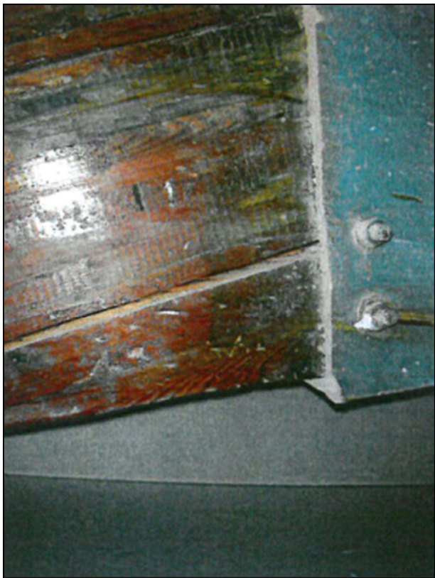
Fot. 85 Widok uszkodzeń drewna w miejscu osadzenia w ostrogach – zdjęcia archiwalne.
