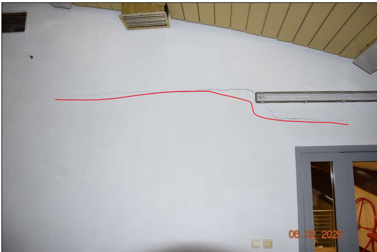
Fot. 234. Pęknięcia na wewnętrznych ścianach działowych spowodowane zmianą sposobu użytkowania korytarzy – wprowadzono urządzenia do ćwiczeń które generują obciążenia dynamiczne. Brak wpływu na bezpieczeństwo konstrukcji. (fot. Rafał Fit)
