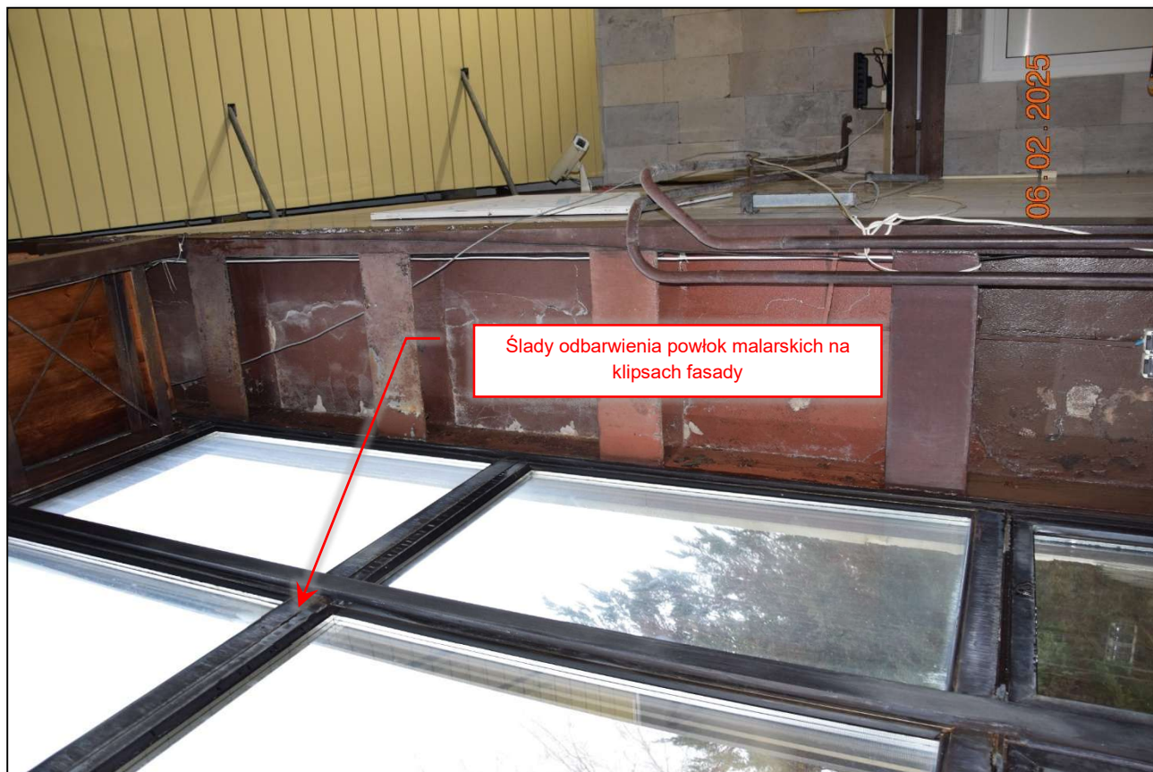
Fot. 158 Ślady utraty właściwości ochronnych powłok malarskich. (fot. Rafał Fit)
