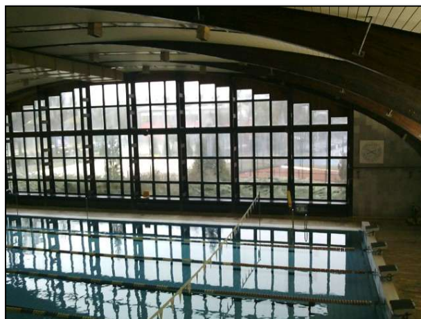
Fot. 108. Na zdjęciach termowizyjnych przedstawiono rozkład temperatury we wnętrzu pomieszczenia basenu, największe straty zaobserwować można w miejscu podparcia dźwigarów na ścianie zewnętrznej oraz na fasadzie metalowo- szklanej, potwierdza się wynik badania fasady z zewnątrz – większe straty ciepła widoczne są na elementach konstrukcji, niż na szybach
