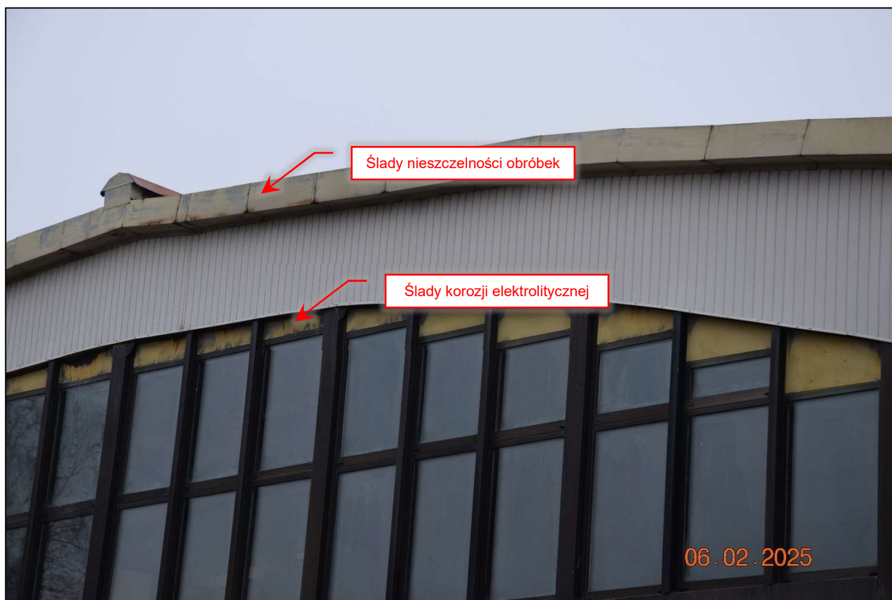
Fot. 145 Widoczne ślady rozwijającej się korozji na skutek zastosowania stalowych paneli wpiętych w aluminiową konstrukcję. Korozja galwaniczna powoduje rdzewienie elementów stalowych oraz utlenianie aluminium przez co dochodzi do osłabienia nośności przekroji konstrukcyjnych. (fot. Rafał Fit)
