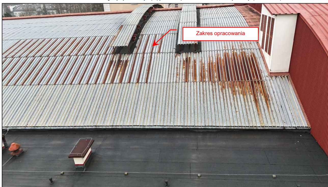
Fot. 119 Widok ognisk postępującej korozji. Stan techniczny poszycia – dostateczny. Blacha nie utraciła jeszcze swoich właściwości jednakże stan wizualny obniża wartość estetyczną obiektu. (fot. Rafał Fit)
