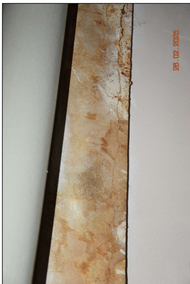
Fot. 58. Inwentaryzacja destrukcji elementów żelbetowych spowodowana oddziaływaniem wody basenowej (fot. Rafał Fit)
