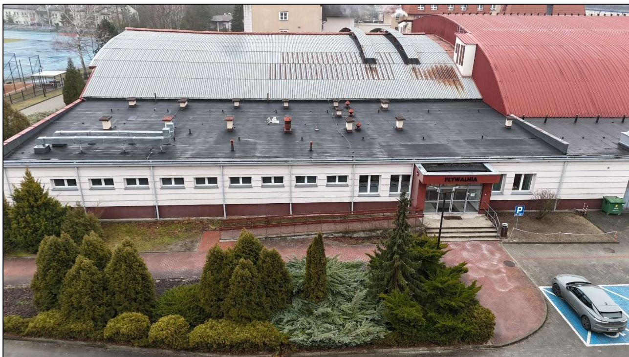
Fot. 130 Widok ogólny elewacji bocznej docieplonej styropianem. Stan techniczny dostateczny. (fot. Rafał Fit)
