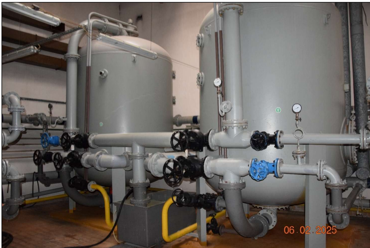
Fot. 195 Widok ogólny instalacji technologicznej funkcjonowania basen. Po 35 latach kontaktu z agresywnym środowiskiem zalecana jest wymiana z uwagi na duże ryzyko pojawiających się awarii rurociągów i armatury odcinającej. (fot. Rafał Fit)
