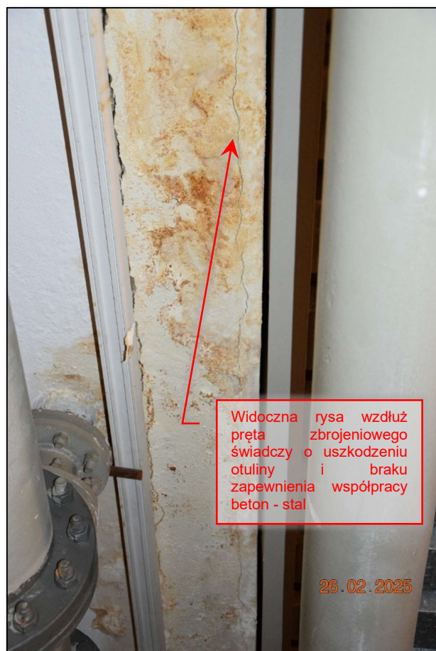
Fot. 229 Inwentaryzacja stanu technicznego konstrukcji nośnej w pomieszczeniu technicznym niecki basenowej – stan techniczny dostateczny. (fot. Rafał Fit)
