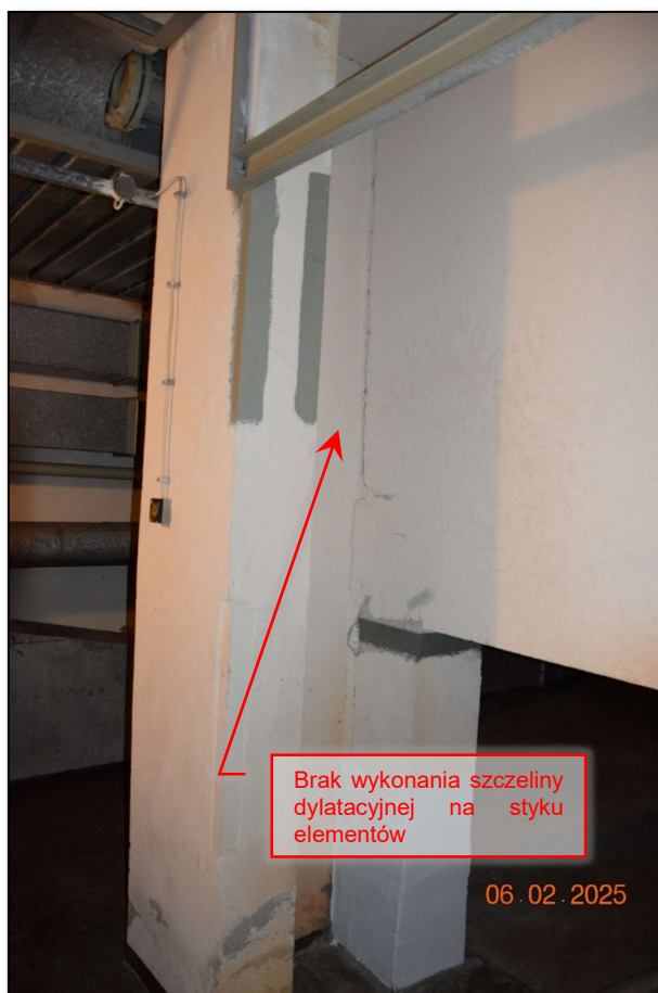
Fot. 214 Inwentaryzacja stanu technicznego konstrukcji nośnej w pomieszczeniu technicznym niecki basenowej – stan techniczny dostateczny. (fot. Rafał Fit)
