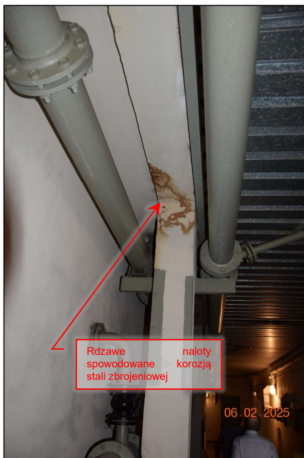
Fot. 218 Inwentaryzacja stanu technicznego konstrukcji nośnej w pomieszczeniu technicznym niecki basenowej – stan techniczny dostateczny. (fot. Rafał Fit)
