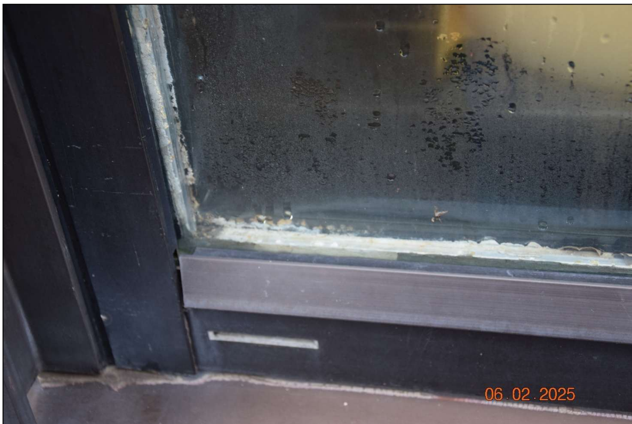
Fot. 154 Detal uszkodzonych pakietów szybowych fasady aluminiowo – szklanej. Stan techniczny – zły. (fot. Rafał Fit)
