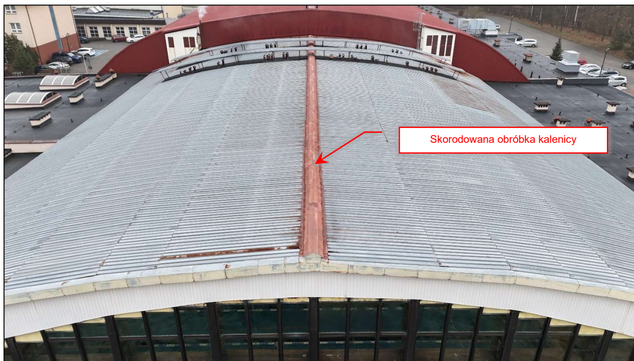
Fot. 115 Obróbki blacharskie kalenicy i ściany szczytowej – stan techniczny dostateczny. Widoczne ślady postępującej korozji (fot. Rafał Fit)
