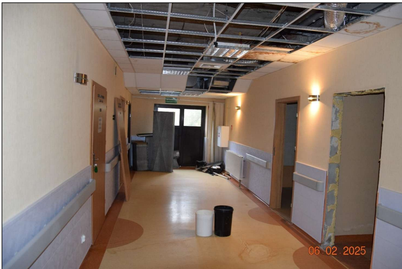
Fot. 250. Widok ogólny stropodachu żelbetowego – stan techniczny dobry. Widoczne lokalne przecieki z poszycia dachu. (fot. Rafał Fit)
