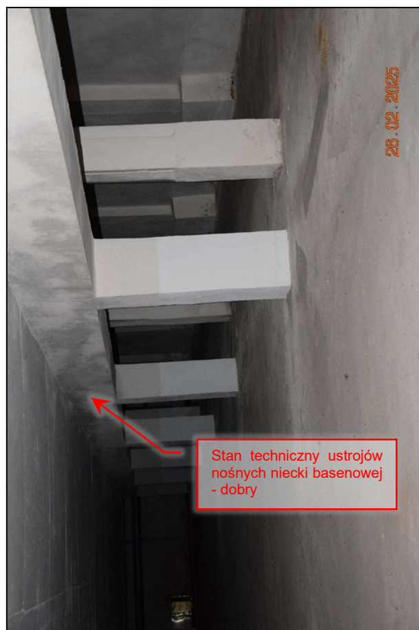
Fot. 219 Inwentaryzacja stanu technicznego konstrukcji nośnej w pomieszczeniu technicznym niecki basenowej – stan techniczny dostateczny. (fot. Rafał Fit)
