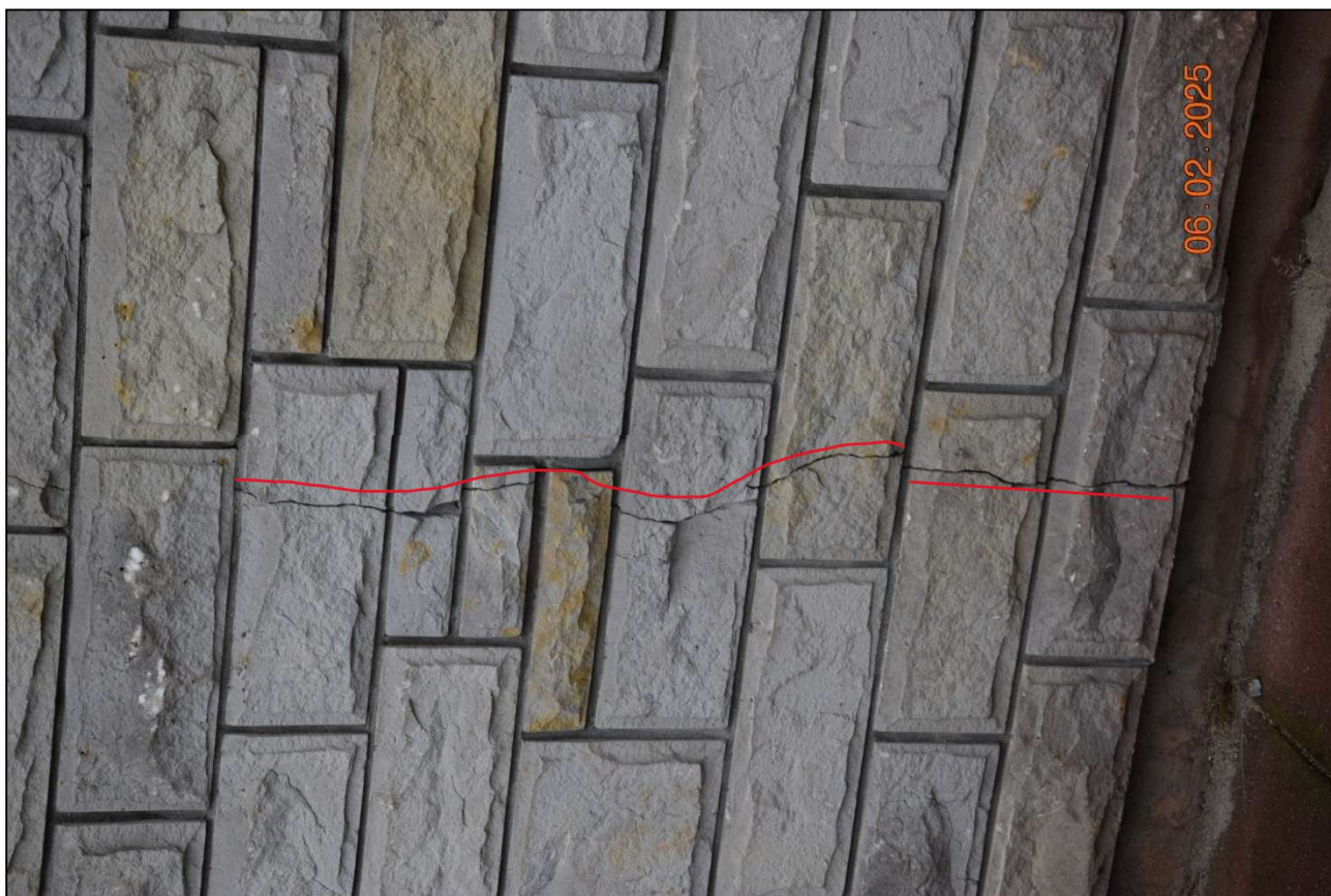
Fot. 135 Widok uszkodzonych okładzin kamiennych spowodowanych korozją mrozową. Brak widocznych pęknięć po drugiej stronie przegrody i ścianach fundamentowych (fot. Rafał Fit)
