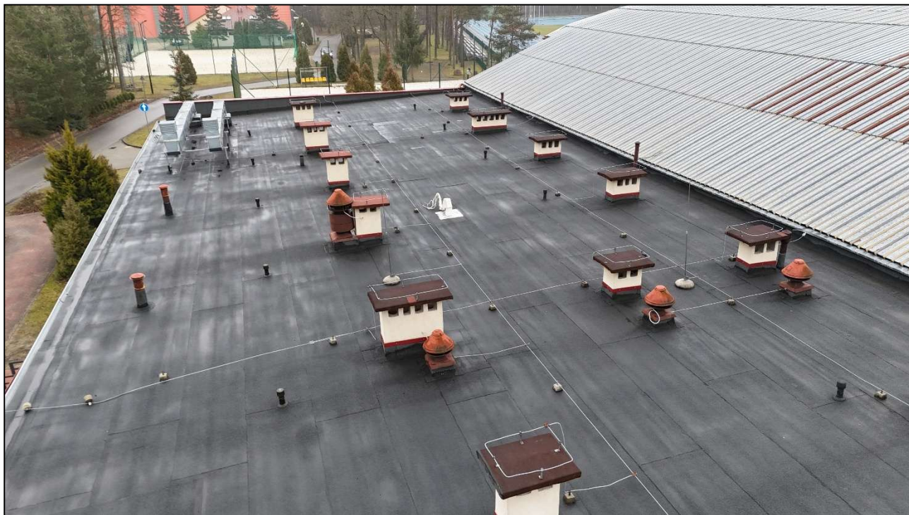
Fot. 118 Widok ogólny hydroizolacji z papy dachów płaskich. Stan techniczny - dobry. (fot. Rafał Fit)
