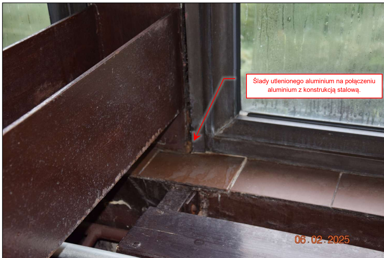
Fot. 159 Detal postępującej korozji galwanicznej na styku dwóch różnych materiałów. Korozja ta jest o tyle niebezpieczna ponieważ osłabia nośność przekroju. (fot. Rafał Fit)
