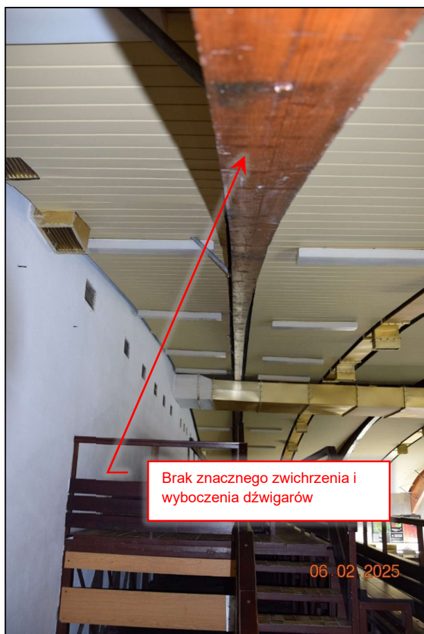
Fot. 87 Analiza stanu technicznego drewnianych dźwigarów hali basenowej (fot. Rafał Fit).
