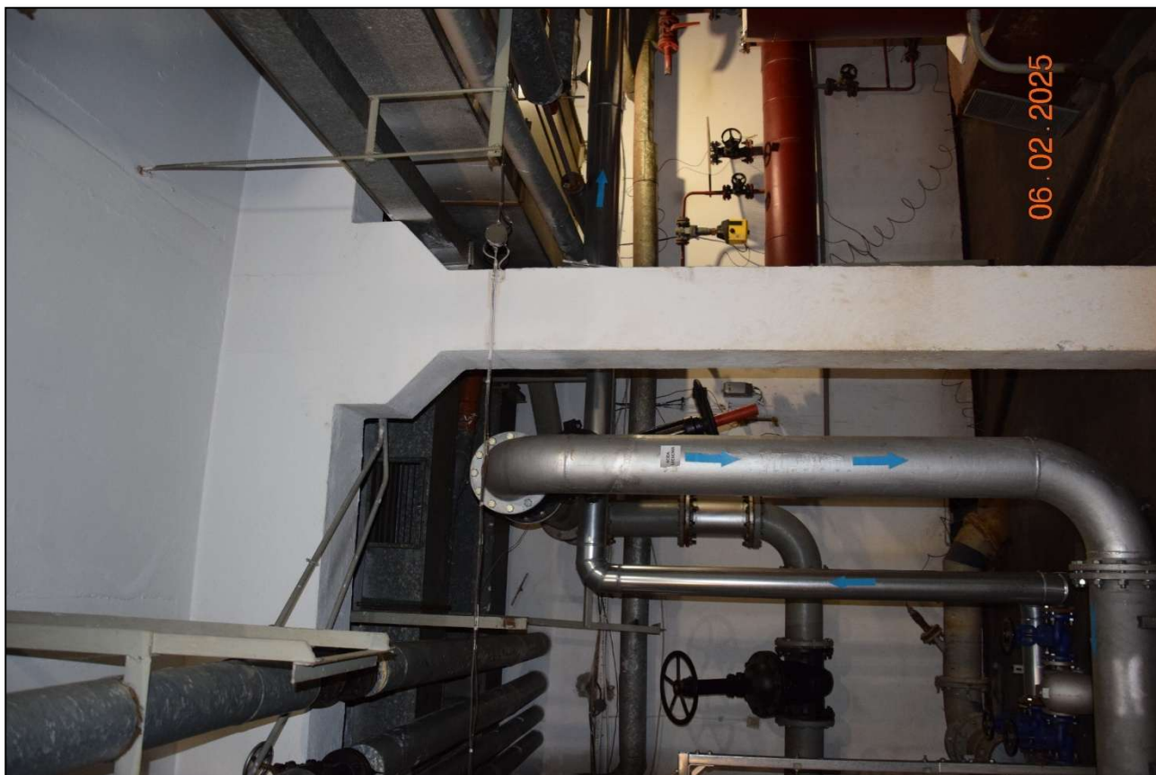
Fot. 204 Widok ogólny konstrukcji nośnej – stan techniczny dobry. Nie stwierdzono występowania karbonatyzacji betonu i śladów przekroczenia stanów granicznych. (fot. Rafał Fit)
