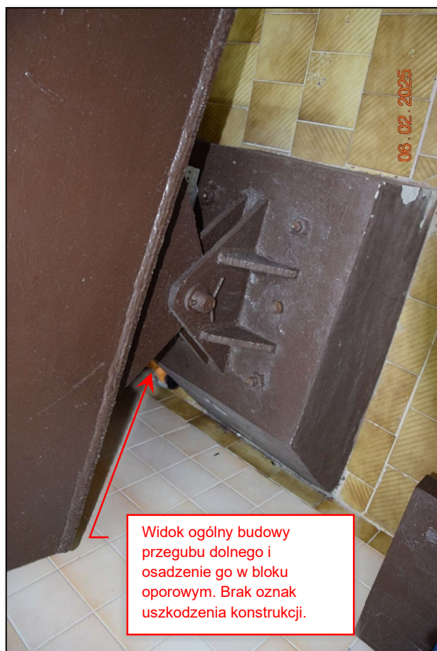
Fot. 88 Analiza stanu technicznego drewnianych dźwigarów hali basenowej (fot. Rafał Fit).
