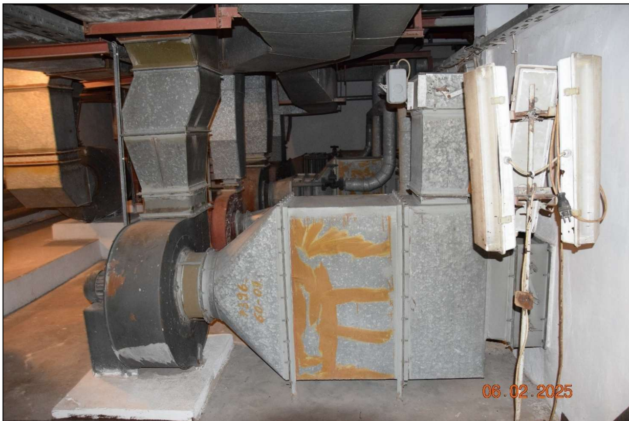
Fot. 207 Widoczne zużycie kanałów wentylacyjnych wykonanych z blachy ocynkowanej. Stan techniczny - zły. Zalecana wymiana. (fot. Rafał Fit)
