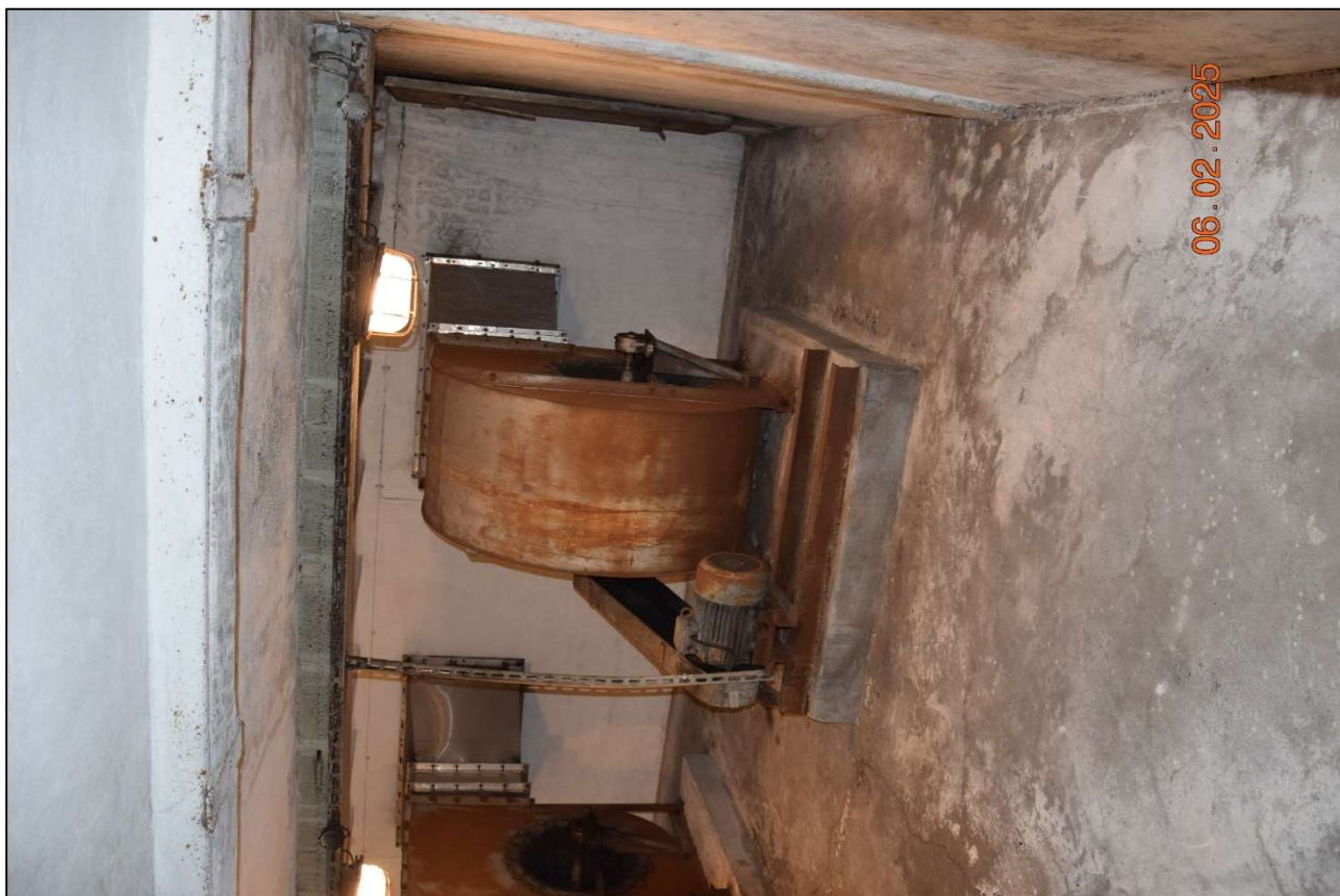
Fot. 212 Urządzenia wentylatorowe – stan techniczny zły. Skorodowane obudowy, brak osłon zabezpieczających .(fot. Rafał Fit)
