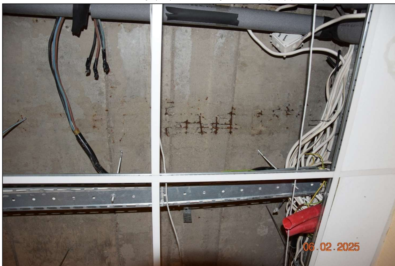
Fot. 245. Widok ogólny stropodachu żelbetowego – stan techniczny dobry. Lokalne ubytki otuliny betonowej spowodowane błędami wykonawczymi powstałymi na etapie budowy. Należy zaszpachlować masami naprawczymi na bazie cementu. (fot. Rafał Fit)
