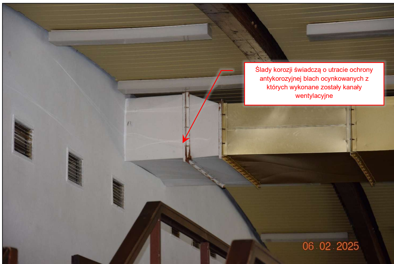
Fot. 240. Widok ogólny kanałów systemu wentylacji mechanicznej. Stan techniczny zły. Uwidocznione ogniska korozji świadczą o utracie warstwy ochronnej ocynku. (fot. Rafał Fit)
