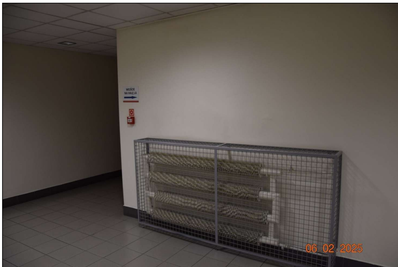
Fot. 241. Widok ogólny grzejników starego typu. Rozwiązanie nieefektywne energetycznie. (fot. Rafał Fit)
