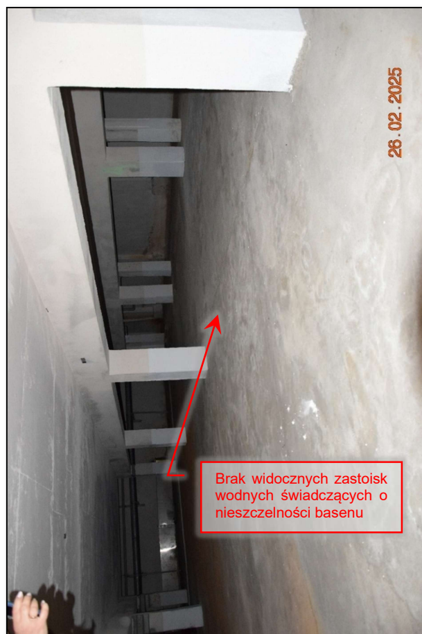
Fot. 221 Inwentaryzacja stanu technicznego konstrukcji nośnej w pomieszczeniu technicznym niecki basenowej – stan techniczny dostateczny. (fot. Rafał Fit)
