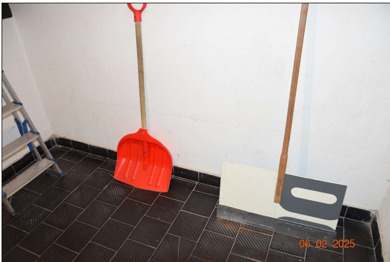
Fot. 189 Ceramiczne okładziny podłogowe w pomieszczeniach technicznych związanych z funkcjonowaniem basenu stan techniczny zły – uległy naturalnemu zużyciu na skutek eksploatacji. (fot. Rafał Fit)
