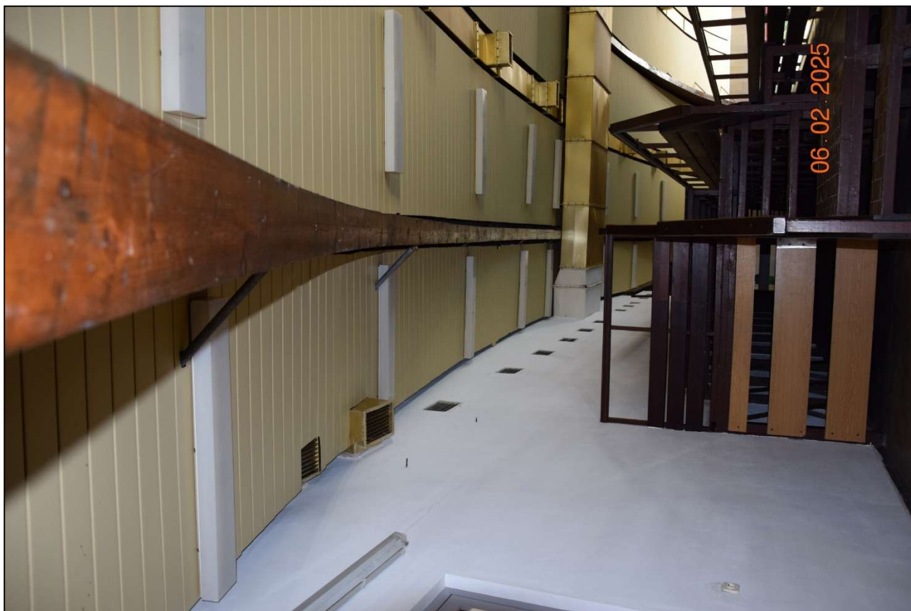
Fot. 172 Analiza wyboczenia i zwichrzenia dźwigarów – nie stwierdzono niepokojących oznak. (fot. Rafał Fit)
