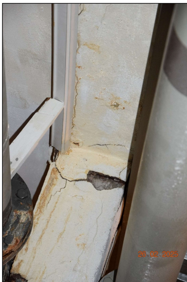
Fot. 58. Inwentaryzacja destrukcji elementów żelbetowych spowodowana oddziaływaniem wody basenowej (fot. Rafał Fit)
