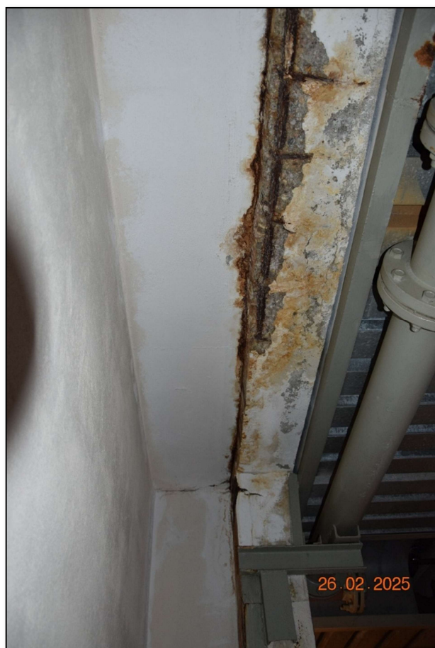
Fot. 55. Inwentaryzacja destrukcji elementów żelbetowych spowodowana oddziaływaniem wody basenowej (fot. Rafał Fit)
