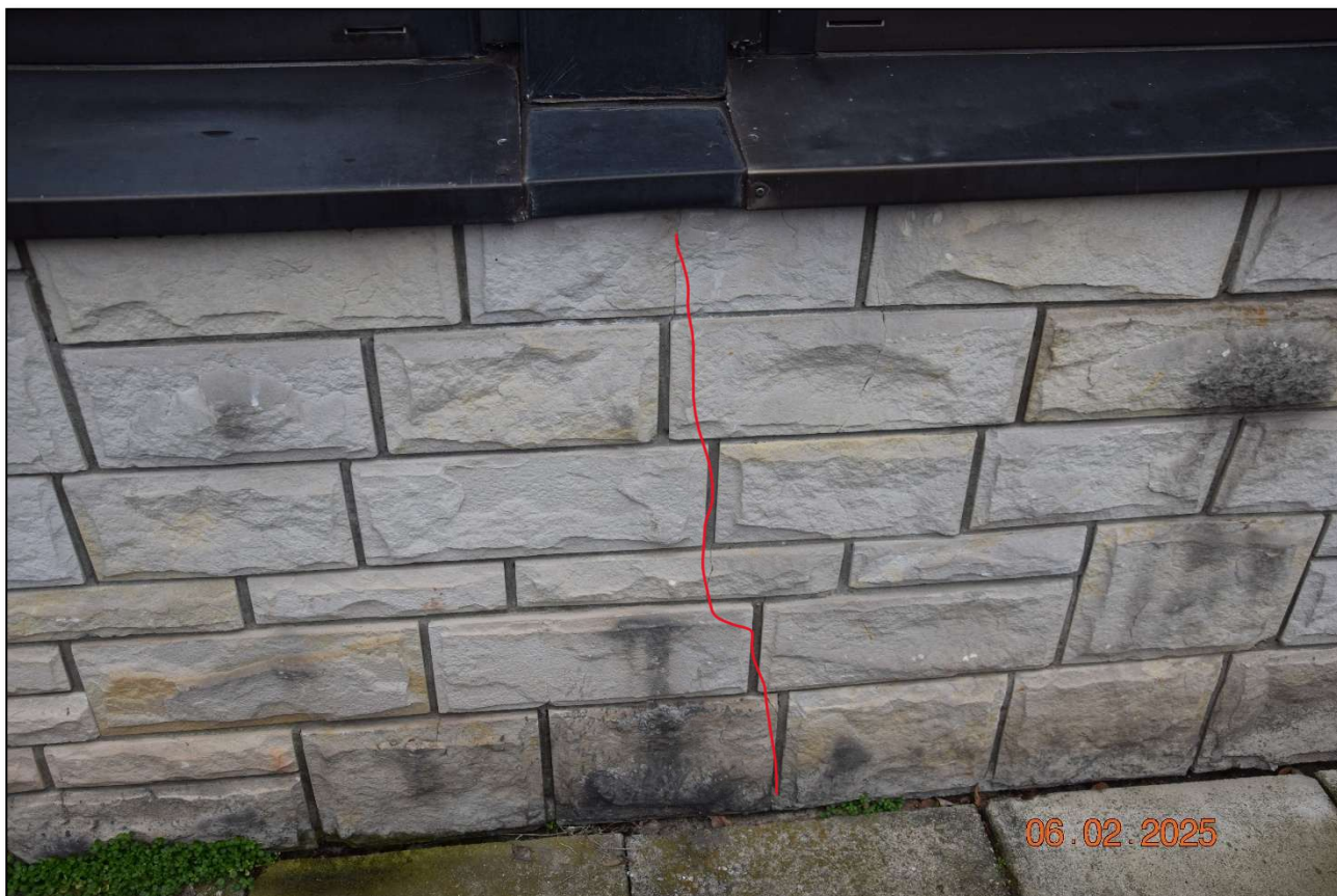
Fot. 132 Pęknięcia okładzin elewacyjnych spowodowane brakiem zapewnienia szczelności obróbek. Woda dostająca się pod okładzinę w okresach ujemnych temperatur zamarza i powoduje uszkodzenia i odspajanie kamienia od podłoża. (fot. Rafał Fit)
