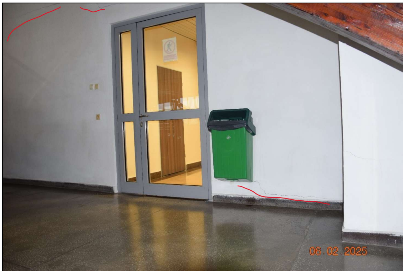
Fot. 233. Pęknięcia na wewnętrznych ścianach działowych spowodowane zmianą sposobu użytkowania korytarzy – wprowadzono urządzenia do ćwiczeń które generują obciążenia dynamiczne. Brak wpływu na bezpieczeństwo konstrukcji. (fot. Rafał Fit)
