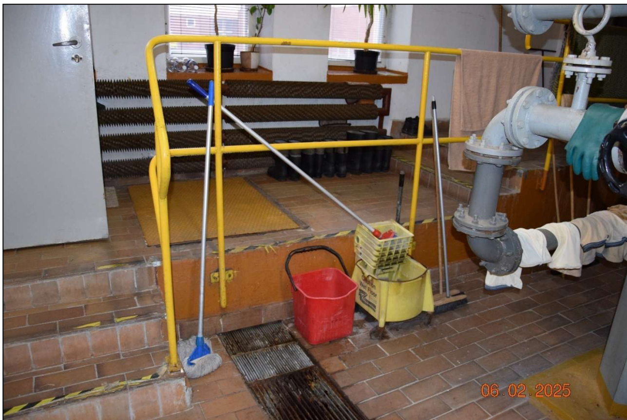
Fot. 198 Widok zużycia okładzin posadzkowych. Zalecana jest również wymiana hydroizolacji poziomej przed przedostawianiem się agresywnej wody oddziaływującej negatywnie na fundamenty. (fot. Rafał Fit)
