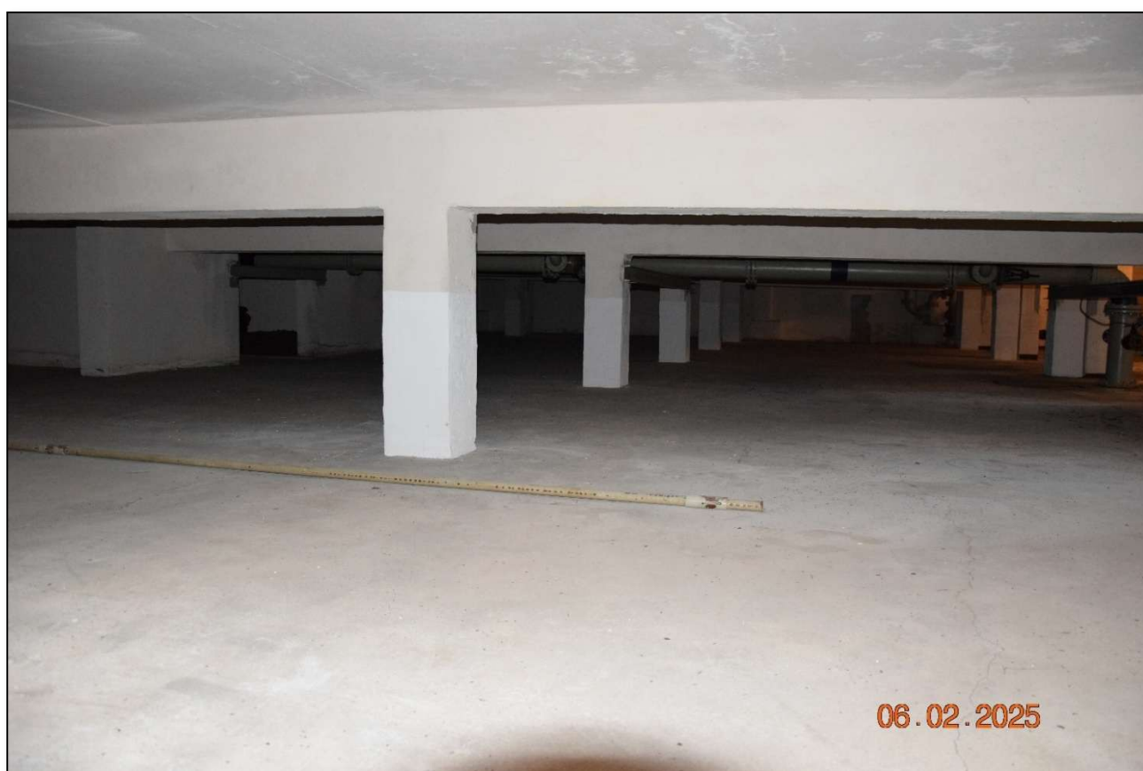
Fot. 26. Brak widocznych śladów nieszczelności płyty stropowej basenu – stan techniczny dobry. (fot. Rafał Fit)
