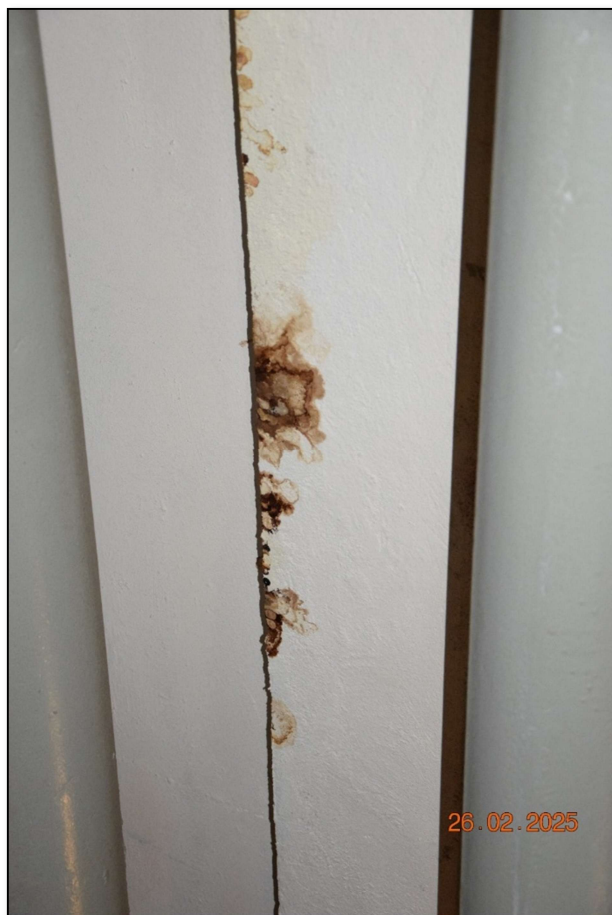
Fot. 57. Inwentaryzacja destrukcji elementów żelbetowych spowodowana oddziaływaniem wody basenowej (fot. Rafał Fit)
