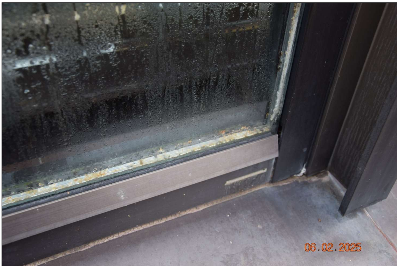
Fot. 152 Detal uszkodzonych pakietów szybowych fasady aluminium – szklanej. Stan techniczny – zły. (fot. Rafał Fit)
