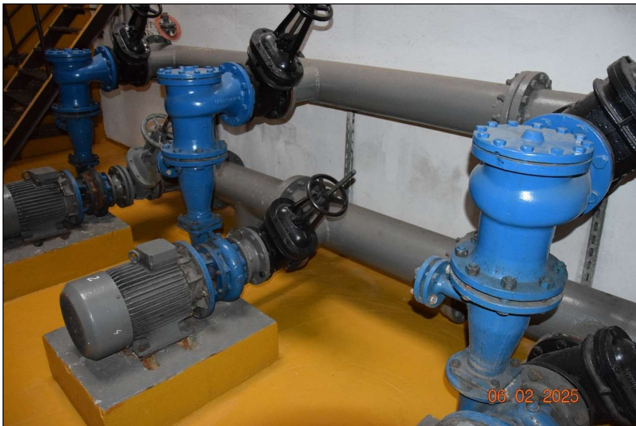
Fot. 193 Widok ogólny instalacji technologicznych funkcjonowania basen. Po 35 latach kontaktu z agresywnym środowiskiem zalecana jest wymiana z uwagi na duże ryzyko pojawiających się awarii. (fot. Rafał Fit)
