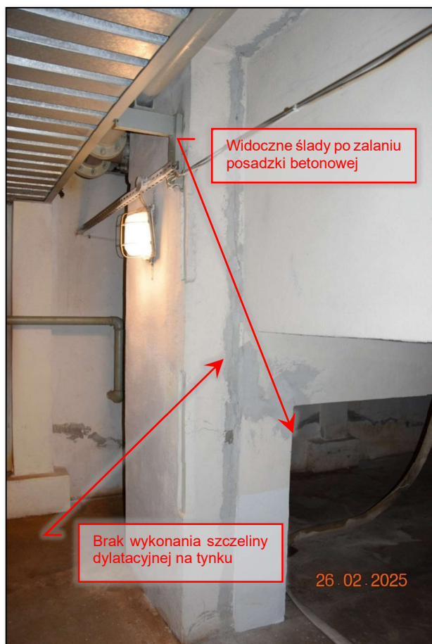
Fot. 229 Inwentaryzacja stanu technicznego konstrukcji nośnej w pomieszczeniu technicznym niecki basenowej – stan techniczny dostateczny. (fot. Rafał Fit)
