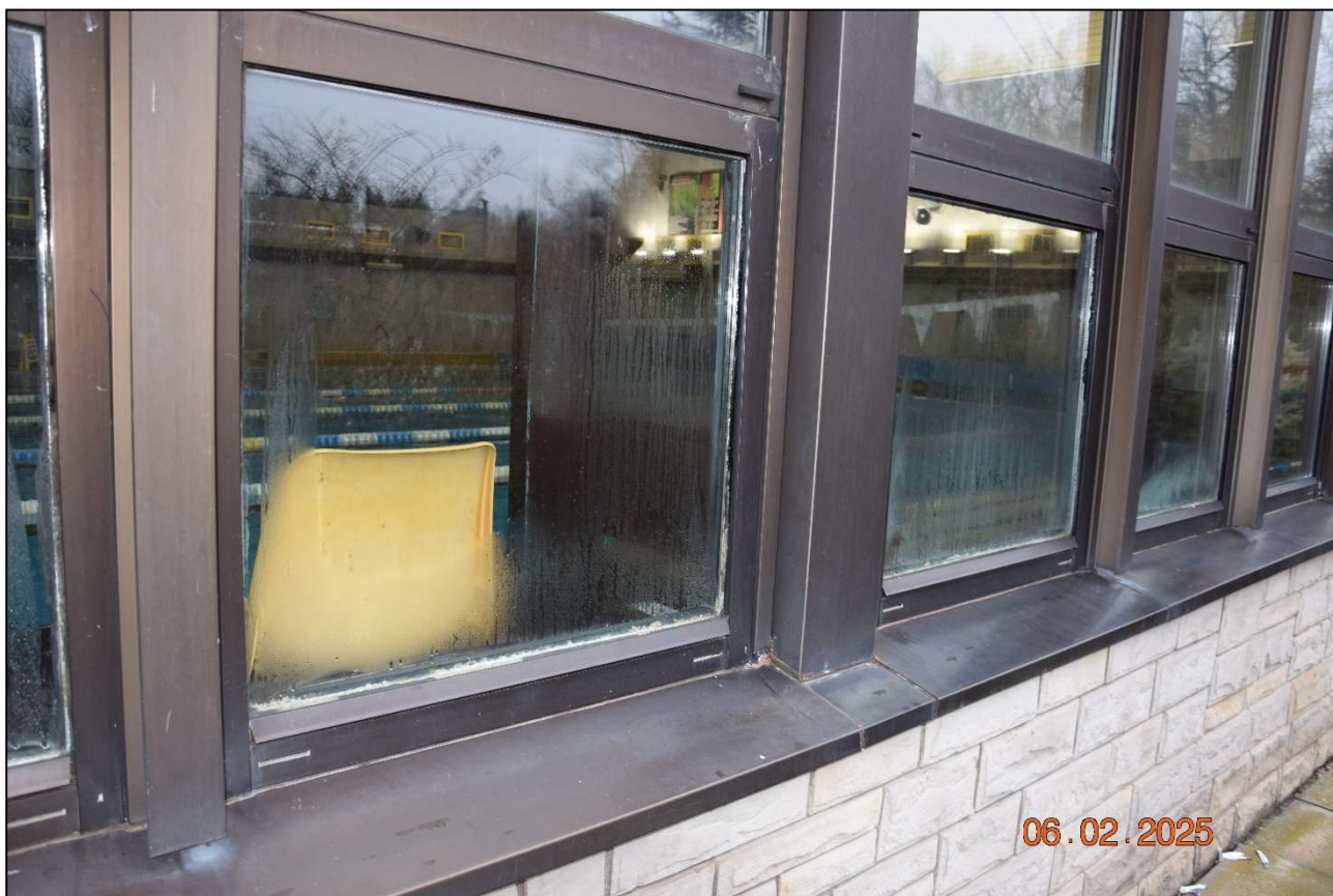
Fot. 153 Detal uszkodzonych pakietów szybowych fasady aluminium – szklanej. Stan techniczny – zły. (fot. Rafał Fit)
