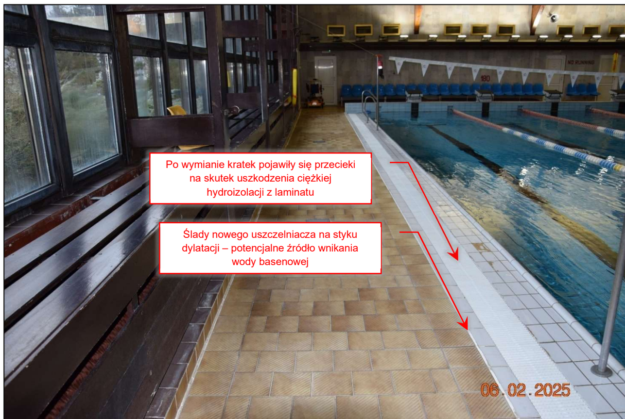
Fot. 180 Widok ogólny okładzin posadzek ceramicznych – stan techniczny zły. Posadzki po 35 latach użytkowania utraciły już swoje właściwości. (fot. Rafał Fit)
