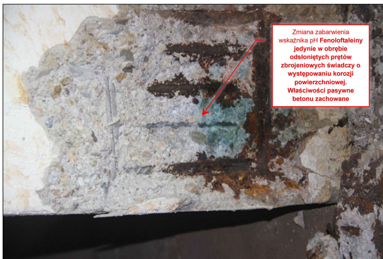
Fot. 19. Widok odsłoniętych prętów zbrojeniowych. Właściwości pasywne betonu w stosunku do stali zbrojeniowej zachowane. Karbonatyzacja ograniczona do miejsca gdzie beton miał dłuższy kontakt z agresywną wodą. (fot. Rafał Fit)
