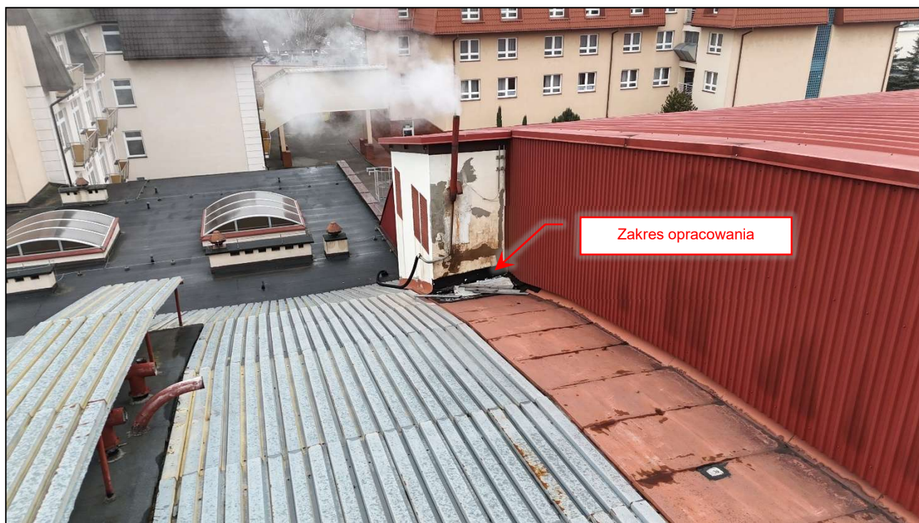
Fot. 121 Widok uszkodzeń obudowy szachtu instalacyjnego. (fot. Rafał Fit)
