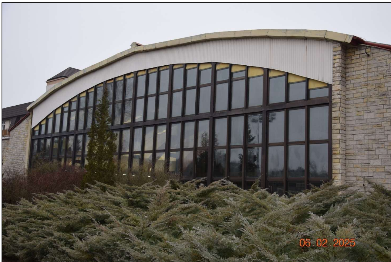
Fot. 143 Widok ogólny fasady aluminiowo – szklanej od strony szczytowej. Stan techniczny - zły(fot. Rafał Fit)
