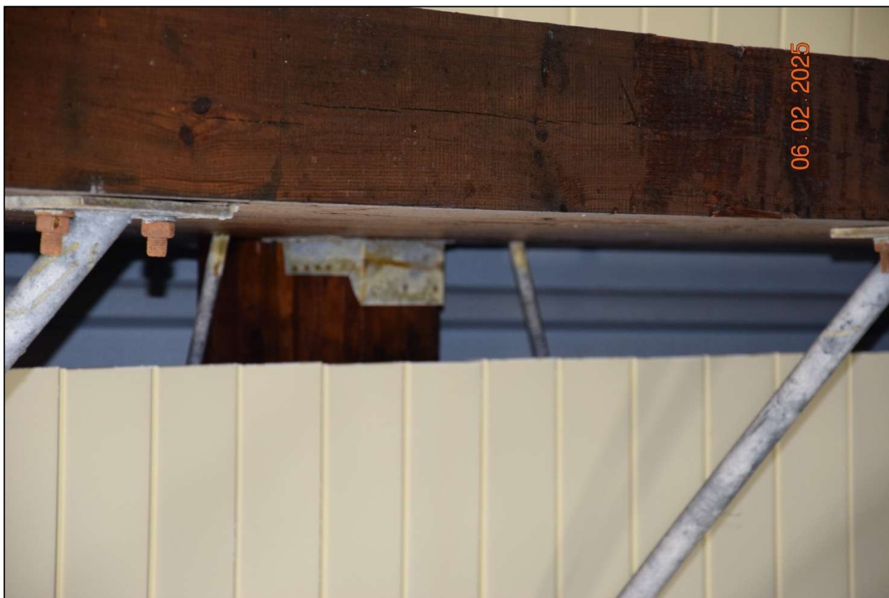
Fot. 175 Detal osadzenia płatwi i mocowanie łączników ciesielskich – nie stwierdzono odspojonych połączeń. Degradacja korozyjna łączników w stopniu niewielkim, nie wpływa na nośność elementu. (fot. Rafał Fit)
