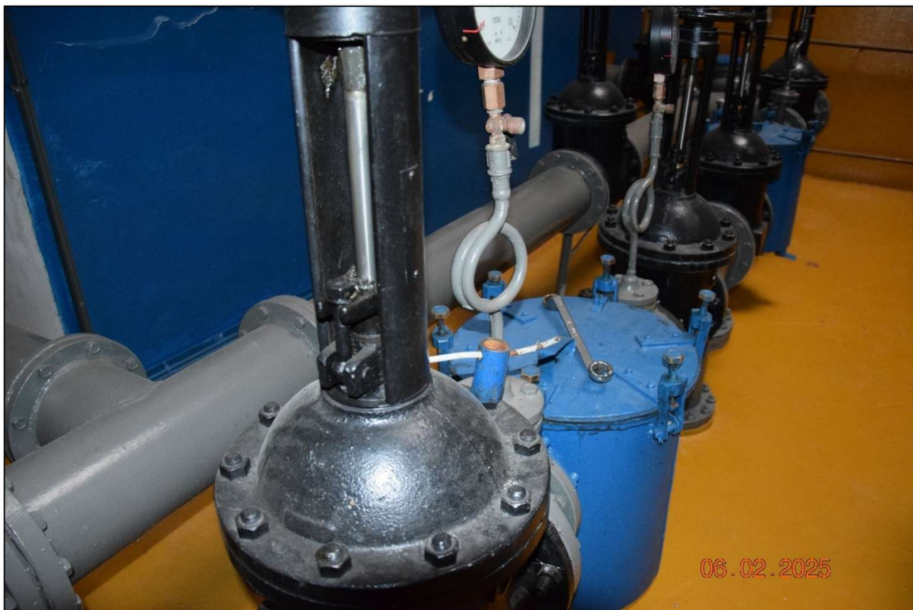
Fot. 192 Widok ogólny instalacji technologicznych funkcjonowania basen. Po 35 latach kontaktu z agresywnym środowiskiem zalecana jest wymiana z uwagi na duże ryzyko pojawiających się awarii. (fot. Rafał Fit)
