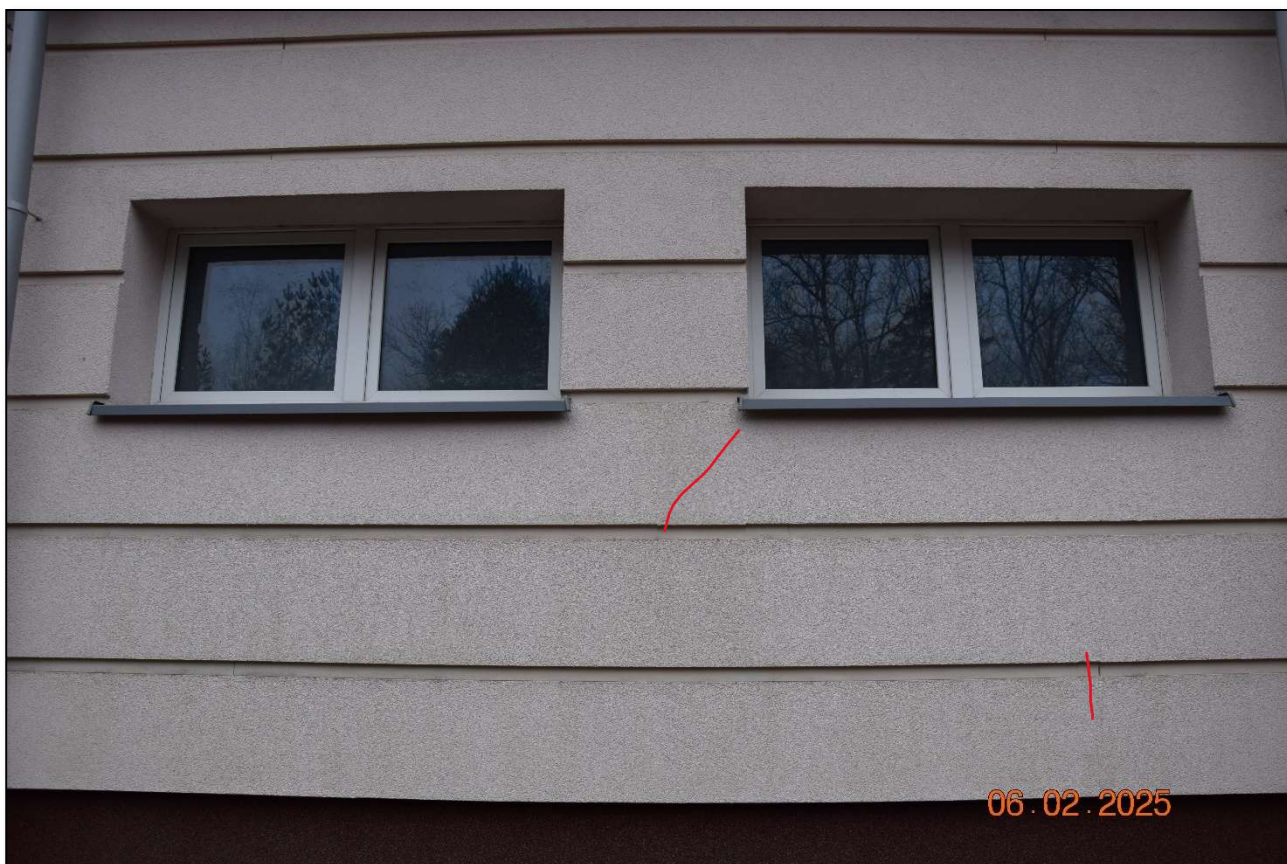
Fot. 139 widok ogólny uszkodzeń elewacji wykonanej w systemie ETICS spowodowane błędami wykonawczymi i okresem eksploatacji. Stan techniczny – dostateczny. (fot. Rafał Fit)
