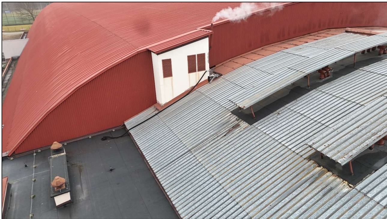
Fot. 122 Widok ogólny detalu połączenia budynku pływalni z halą sportową. Stan techniczny dobry. Nie stwierdzono uszkodzeń ciągłości hydroizolacji. (fot. Rafał Fit)
